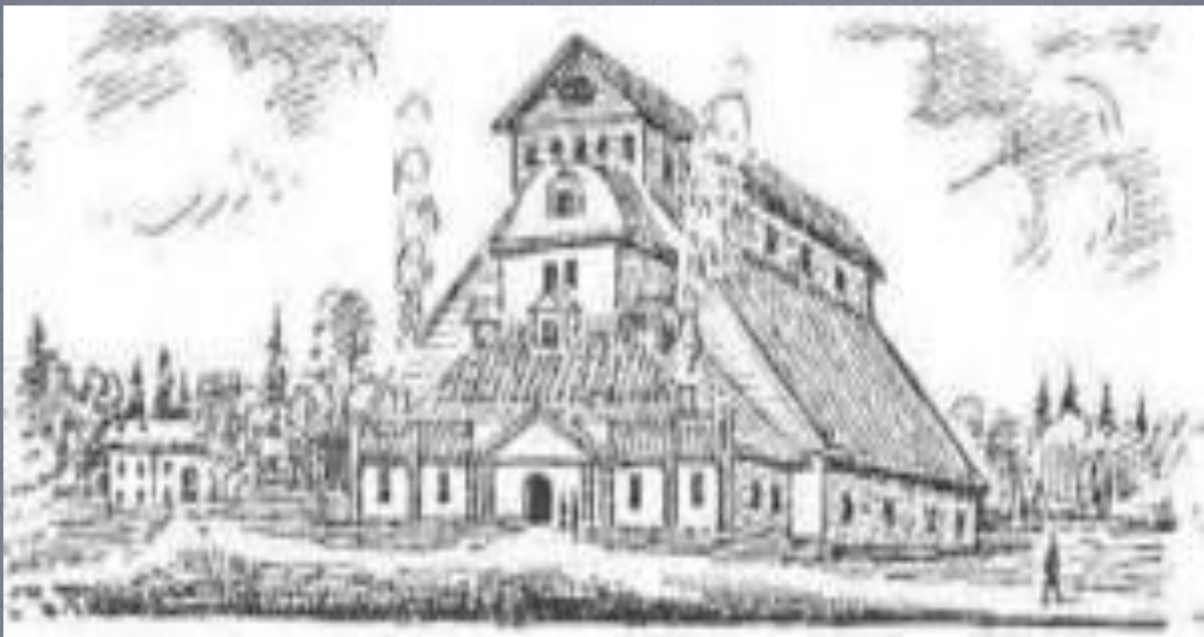
Первый стекольный завод в Петербурге
