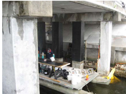
Обмотка полотнами опор
