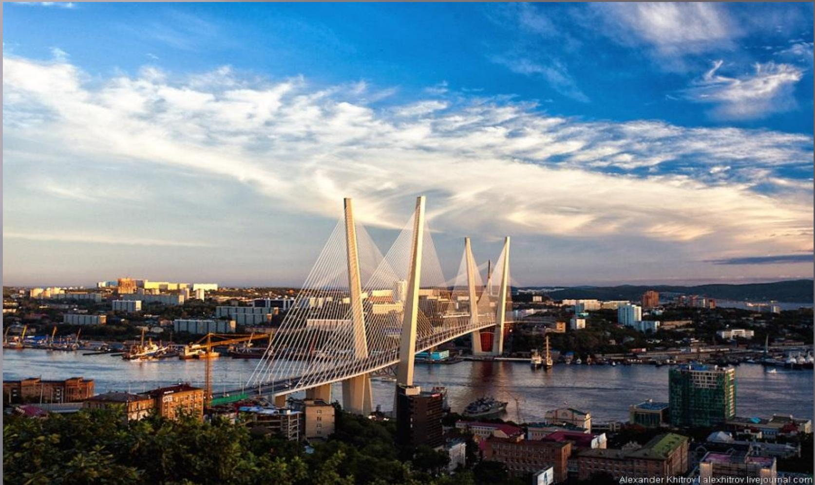
В длину Золотой мост составляет почти 1,4 километра, мостовой переход по основному створу — 2,1 километра, главный пролет протянулся на 737 метров. Над водой он возвышается примерно на 70—80 метров.
