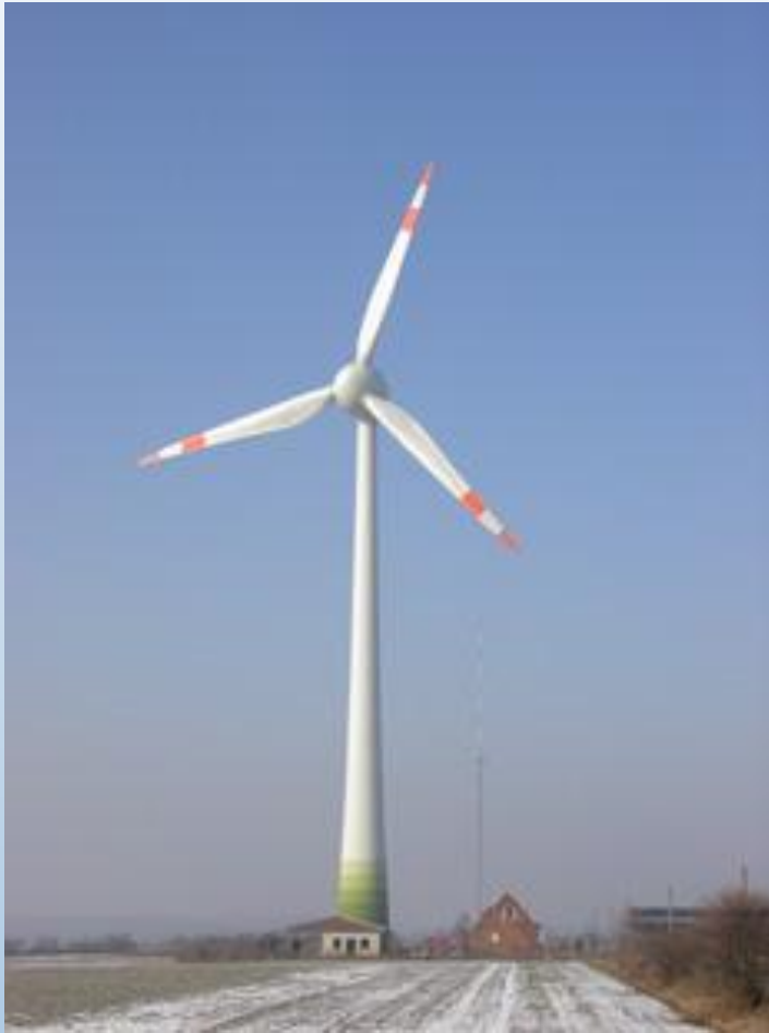
Enercon 4.5MW 112 meter rotor
