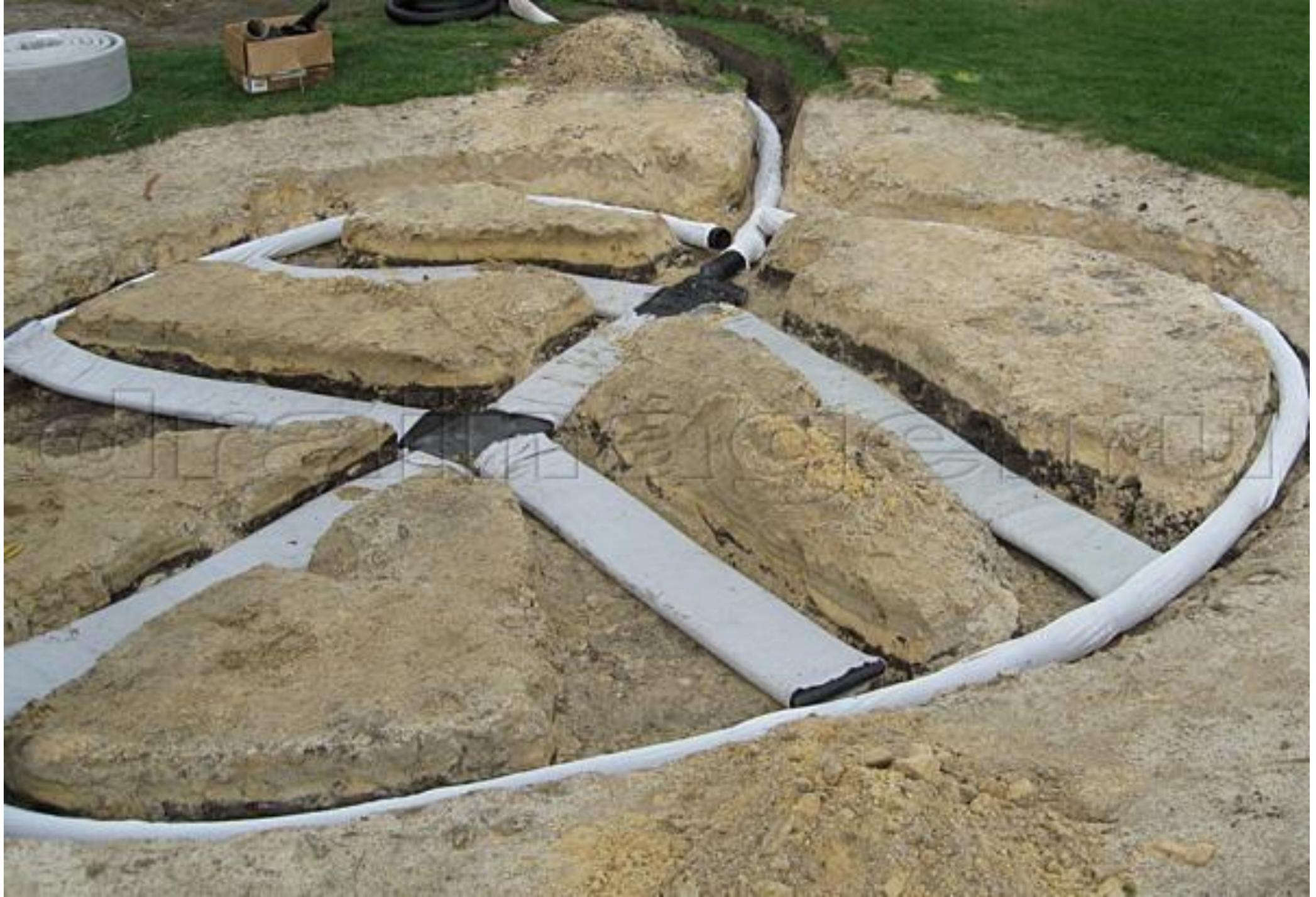
**Горизонтальный дренаж** представляет собой систему трубчатых или галерейных дрен, канав и лотков.
