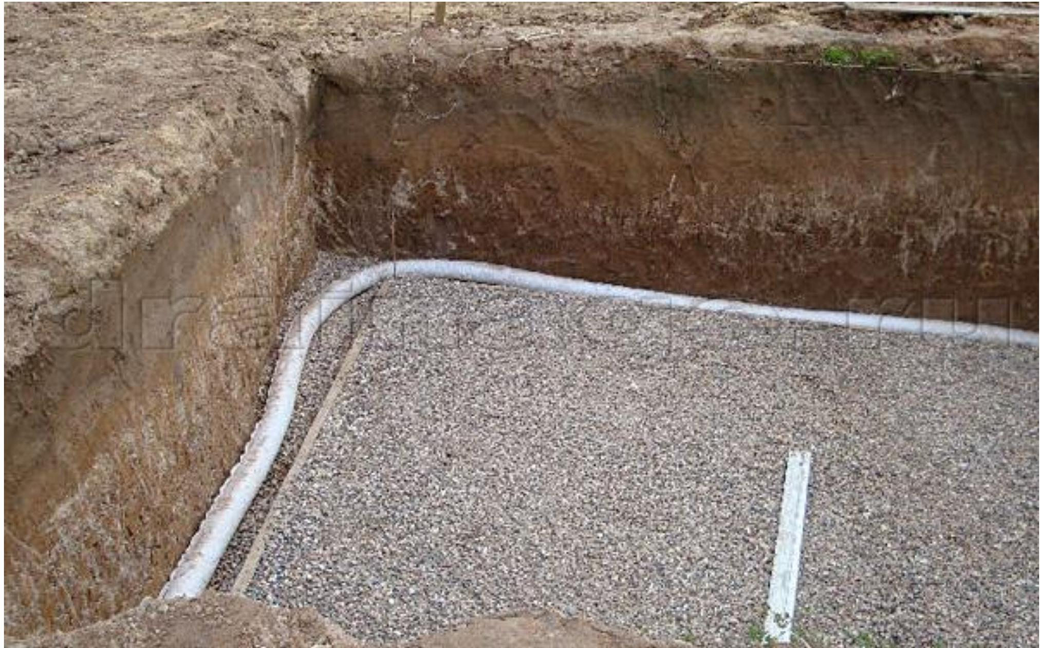
**Пристенная дренажная система** состоит из дренажных труб (с фильтрующей обсыпкой), уложенных на водоупорный грунт с наружной стороны сооружения. Пристенный дренаж применяется, как правило, в тех случаях, когда основание сооружения находится на водоупорном грунте.
