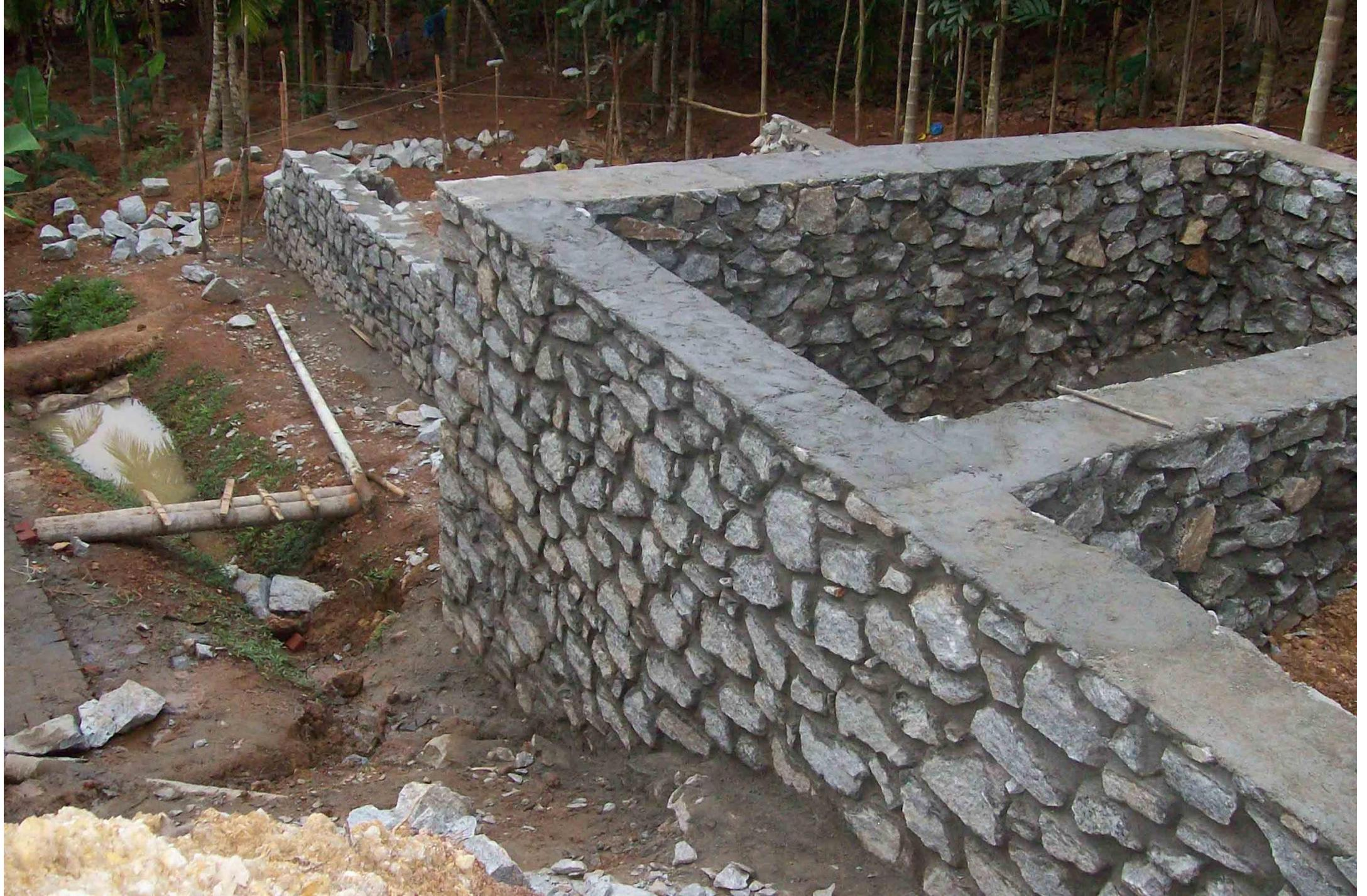
Фундаменты каменных зданий выполнялись сплошными на цементном растворе. Глубина залегания всегда ниже линии промерзания грунта. Уширение фундамента в каждую сторону принято делать в **1/10 сажени на 1 сажень высоты**. Фундаментная лента в сечении имеет симметричную форму.
