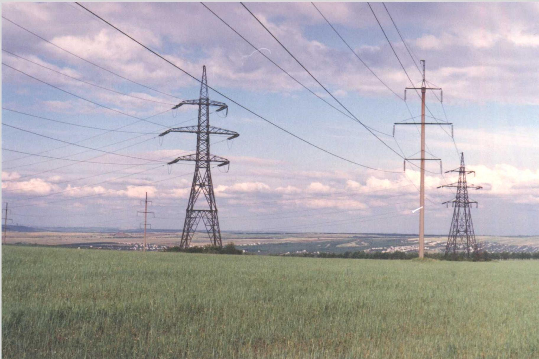
**Рис. 7.18. Двухцепные анкерно-угловая металлическая опора ВЛ 220кВ (слева) и промежуточная железобетонная опора ВЛ 110 кВ (справа)**
