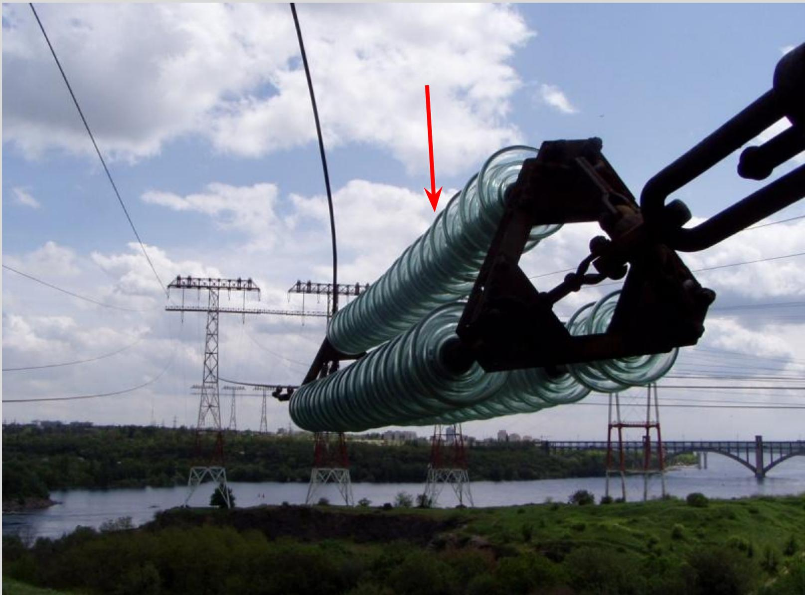
**Рис. 7.6. Натяжная гирлянда концевой опоры ЛЭП**
