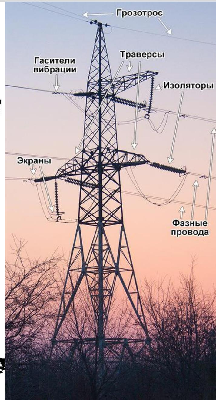
Рис. 7.20. Основные конструктивные элементы металлических опор
