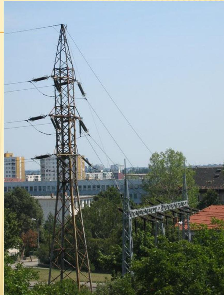
.Концевая металлическая опора
