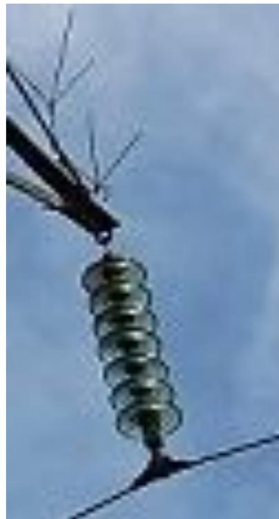
Поддерживающая гирлянда изоляторов закрепляется на траверсе промежуточной опоры при помощи серьги 1. Серьга 1 с одной стороны соединяется со скобой или с деталью на траверсе, а с другой стороны вставляется в шапку верхнего изолятора 2. К нижнему изолятору гирлянды за ушко 3 прикреплен поддерживающий зажим 4, в котором помещен провод 5.
