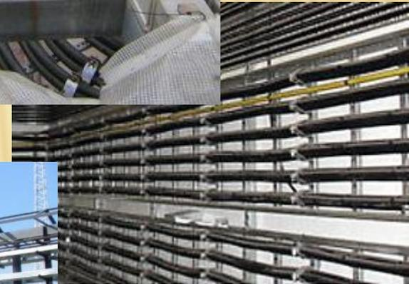
Внутри кабельных сооружений и производственных помещений предусматривают прокладку кабелей на стальных конструкциях различного исполнения
