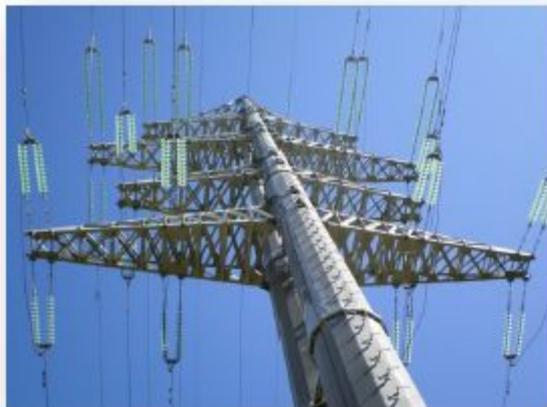
**Подвесные** изоляторы применяются на ВЛ напряжением 35 кВ и выше. Марка изолятора содержит буквы П (подвесной), С (стеклянный) или Ф (фарфоровый), Г (грязестойкий) и А, Б, В, Д (обозначение модификации). Цифрой обозначается максимальная (разрушающая) механическая нагрузка в килоньютонах (кН), например ПФ70-В, ПСП20-А, ПС400-А и т.п.
