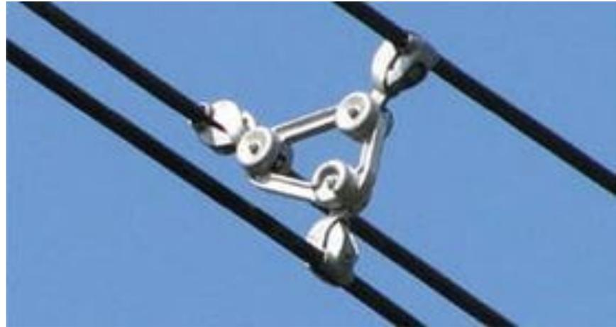
Распорка 1 фиксирует провода расщепленной фазы 2 относительно друг друга. Распорки обеспечивают требуемое расстояние между отдельными проводами фазы и предохраняют их от схлестывания, соударения и закручивания.
