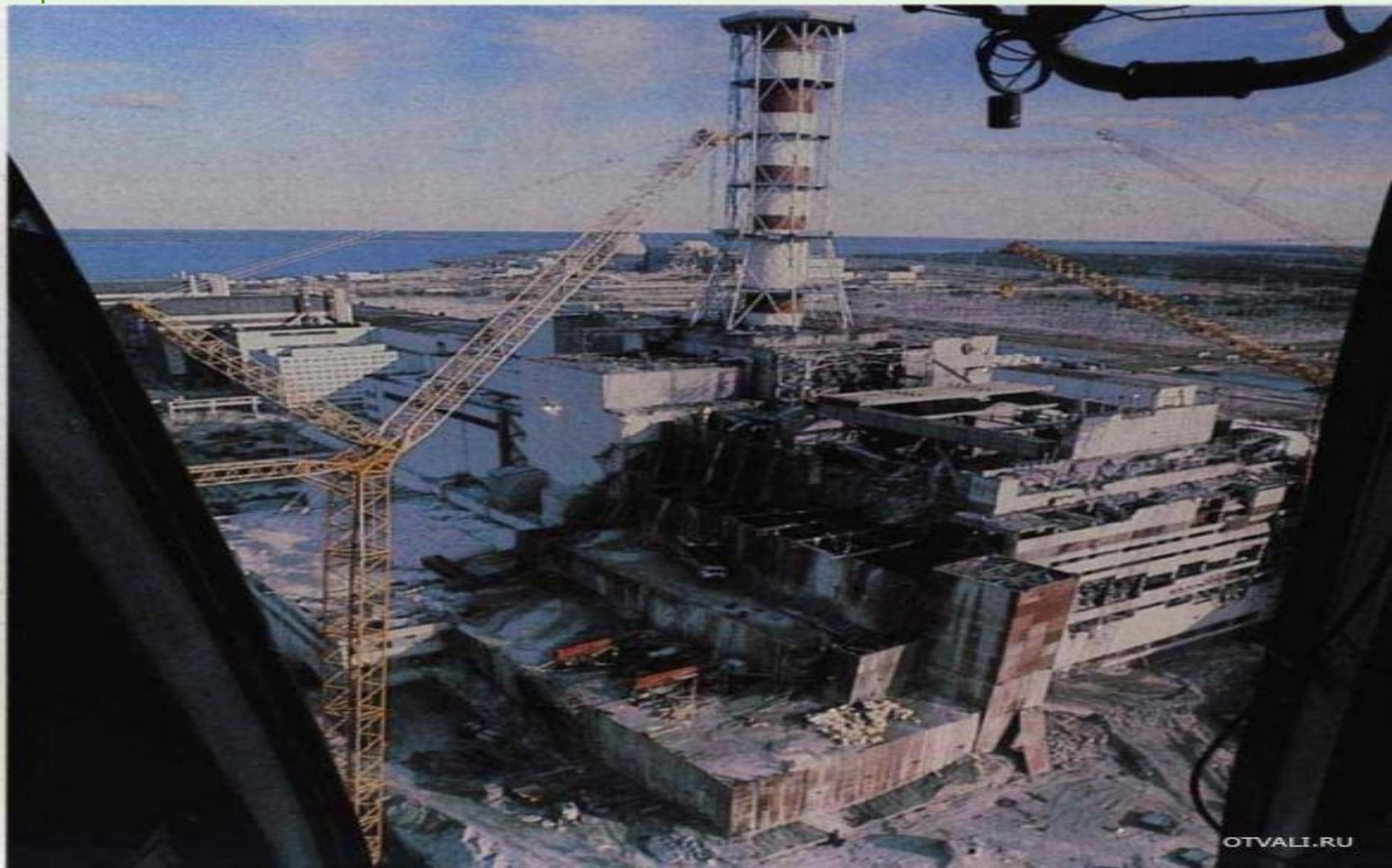
ВЗРЫВ ВЫЗВАЛ МЕХАНИЧЕСКОЕ РАЗРУШЕНИЕ МНОЖЕСТВА ТОПЛИВНЫХ КАССЕТ – ЯДЕРНОГО ГОРЮЧЕГО – ПРИ ЭТОМ ПРОИЗОШЕЛ ВЫБРОС БОЛЕЕ 100 РАЗЛИЧНЫХ НУКЛИДОВ. НА ВОЛЮ ВЫРВАЛОСЬ БОЛЕЕ 8 ТОНН ТОПЛИВА, КОТОРОЕ СОДЕРЖИТ ПЛУТОНИЙ, РАДИОАКТИВНОЕ ГРАФИТОВОЕ ВЕЩЕСТВО. ЭТИ МАТЕРИАЛЫ БЫЛИ РАСПЫЛЕНЫ ВОКРУГ МЕСТА АВАРИИ.
