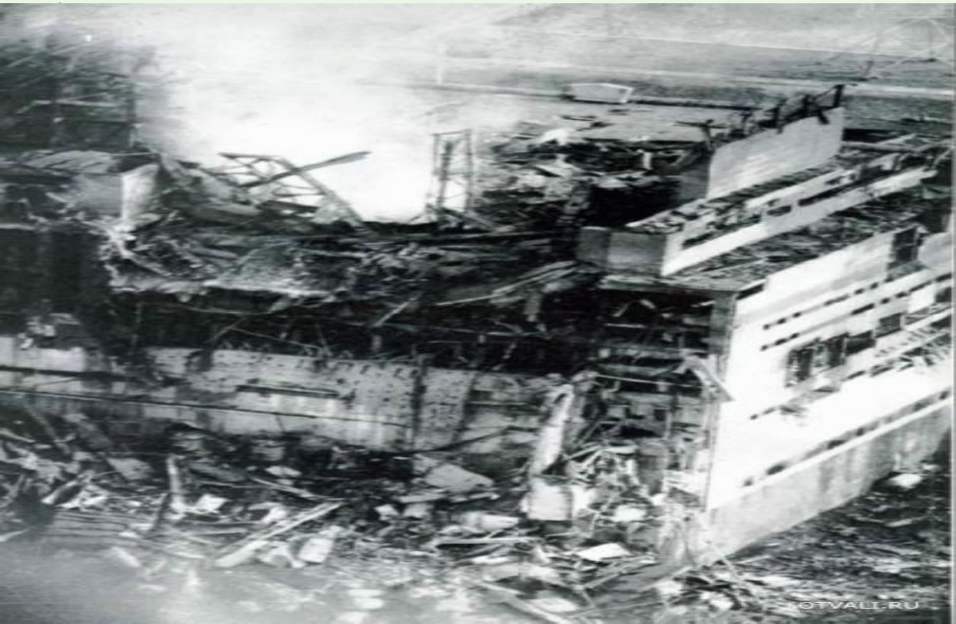
ВЗРЫВЫ СДВИНУЛИ СО СВОЕГО МЕСТА МЕТАЛЛОКОНСТРУКЦИИ ВЕРХА РЕАКТОРА, РАЗРУШИЛИ ВСЕ ТРУБЫ ВЫСОКОГО ДАВЛЕНИЯ, ВЫБРОСИЛИ НЕКОТОРЫЕ РЕГУЛИРУЮЩИЕ СТЕРЖНИ И ГОРЯЩИЕ БЛОКИ ГРАФИТА, РАЗРУШИЛИ ЧАСТЬ ЗДАНИЯ.
