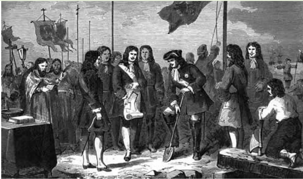
Закладка (основание) Санкт-Петербурга
