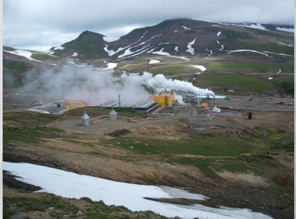
Мутновская геотермальная станция
