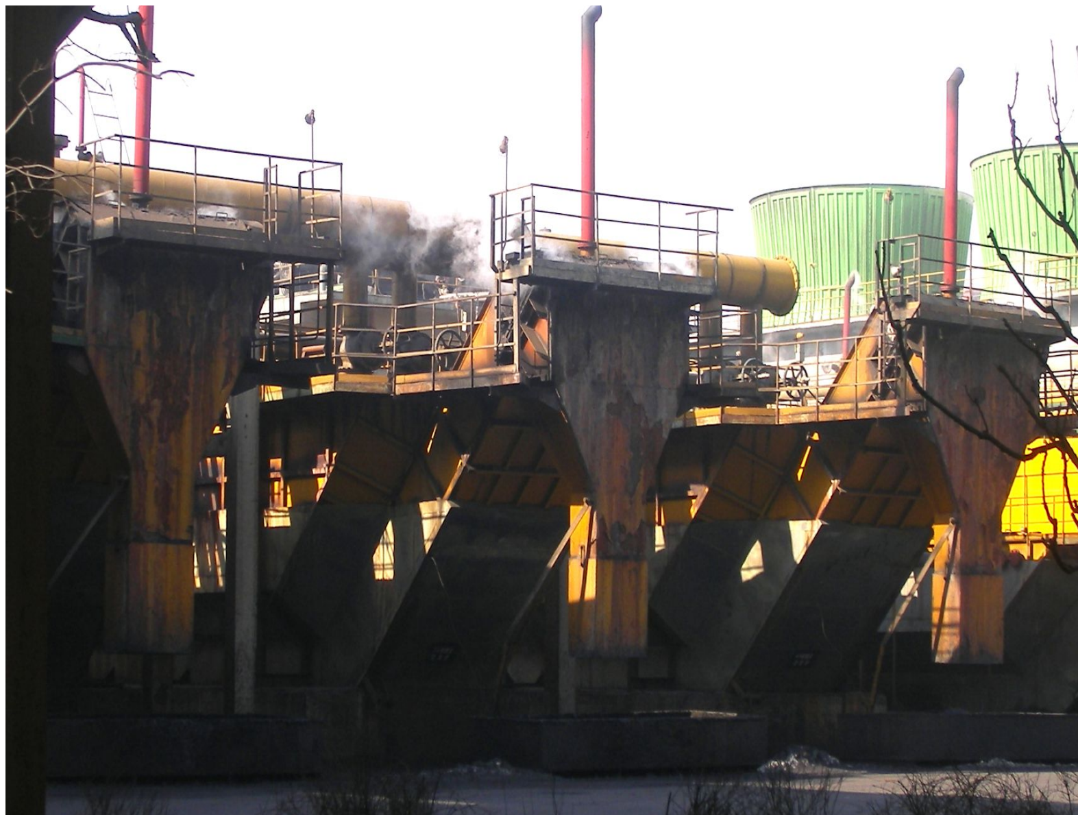
Механизированный осветлитель 380 м3
