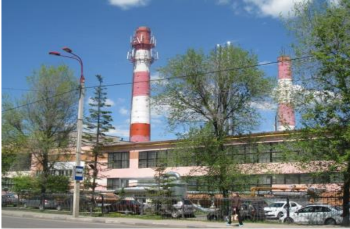
Котельная №21 ул. Звездная
