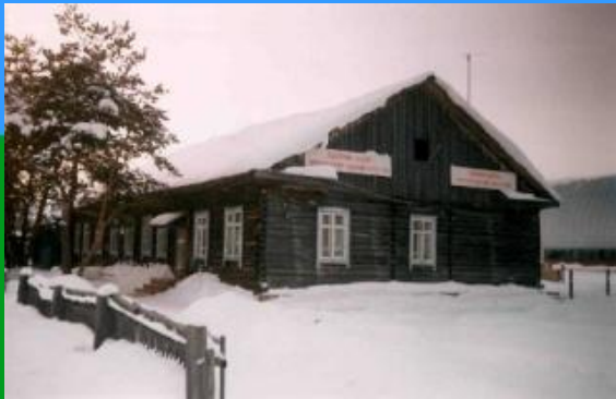
Здание больницы, фото 1986г.
