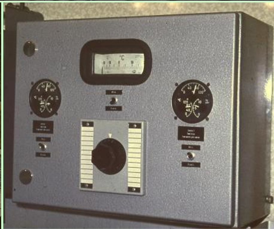
Штатная телетермометрическая станция
