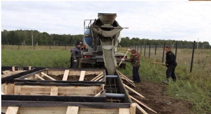
Ширина траншеи под ленточный фундамент подбирается с учетом размеров конструкции, опалубки, толщины изоляции и креплений с добавлением 0,2 м с каждой стороны.
