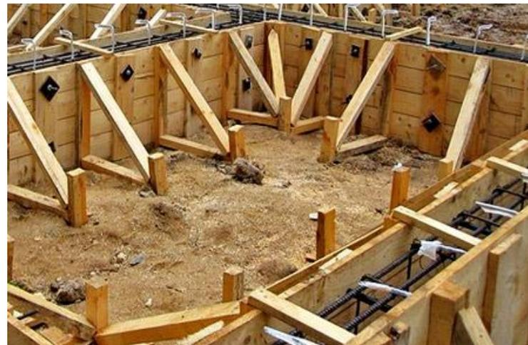
Для изготовления арматурного каркаса фундамента в качестве основного материала в данной работе принята арматурная сталь класса А-III, марки 35ГС диаметром 12 и 20 мм.
