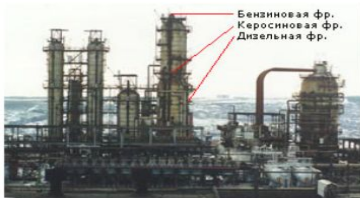
Рис.3. Установка ЭЛОУ-АВТ-6 Саратовского НПЗ. В центре - атмосферная колонна (показаны точки отбора фракций), справа - вакуумная.
