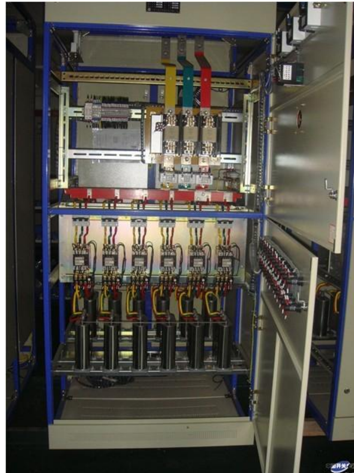
Электрощитовая сборка НКУ
