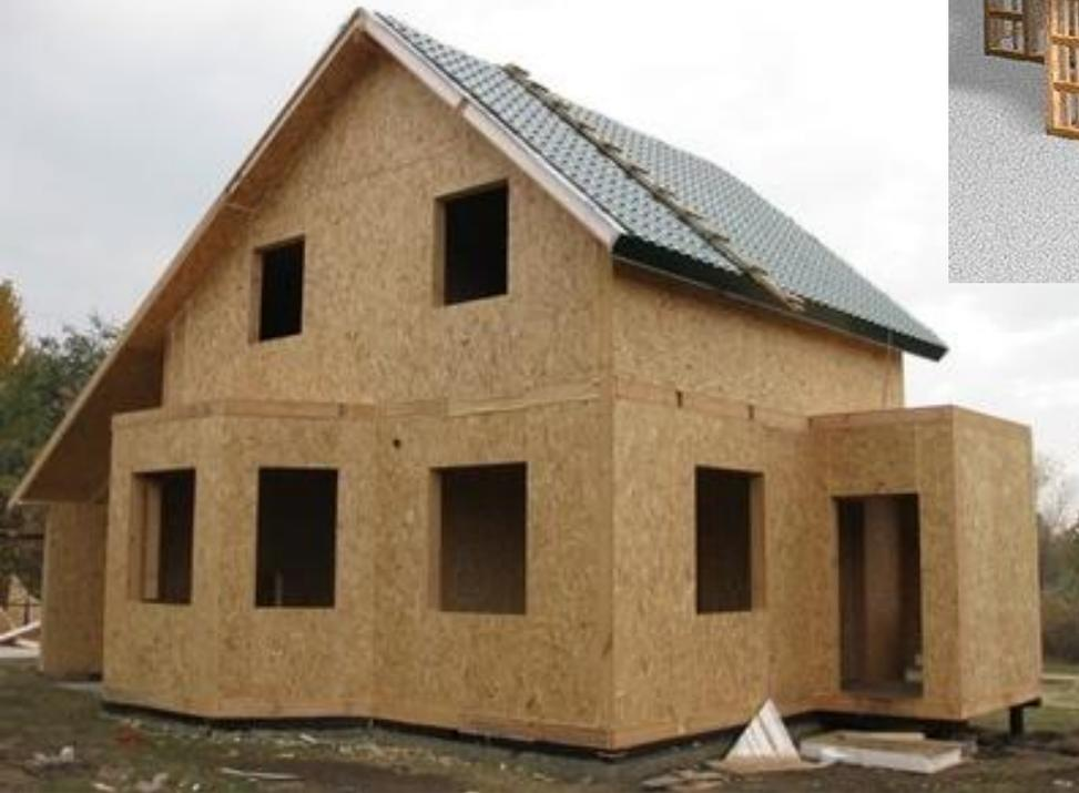
**Каркас состоит из обработанного соснового бруса и досок, обшивка выполняется из древесно-стружечных плит с утеплением и наружной облицовкой**
