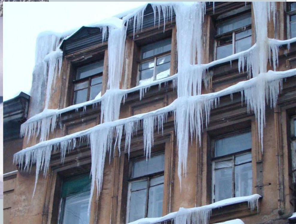
Снег и наледи на крышах являются источником серьезной опасности как для окружающих, так и для самой конструкции покрытия, превращаясь за зиму в значительную снеговую нагрузку
