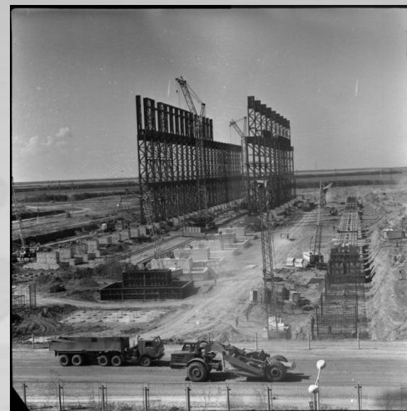
Строительство 3-го корпуса завода "Атоммаш".
