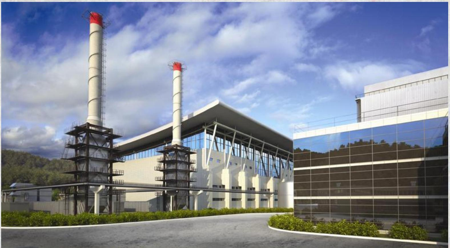
**Количество отбираемого пара зависит от потребности в тепловой энергии. Хотя коэффициент полезного действия ТЭЦ и достигает 60-70%, такая система является довольно-таки непрактичной. В отличие от электрокабеля, надежность теплотрасс на больших расстояниях чрезвычайно низка, следовательно, эффективность централизованного теплоснабжения при передаче тоже сильно понижается.**
