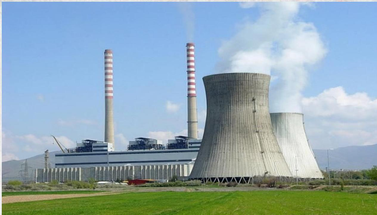
**В городах же чаще используются ТЭЦ - теплоэлектроцентрали, производящие и тепло в виде горячей воды. От конденсационной станции она отличается установленной специальной теплофикационной турбиной с отбором пара. Одна часть пара полностью используется в турбине для выработки электроэнергии генератором и затем поступает в конденсатор, а другая, имеющая большую температуру и давление, отбирается от промежуточной ступени турбины для теплоснабжения.**
