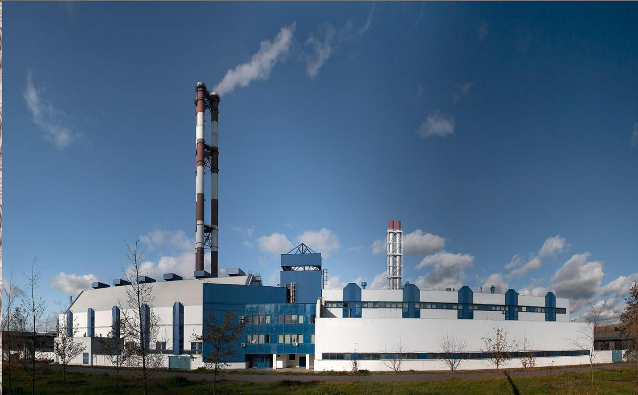
**Опишем простейшую технологическую цепочку КЭС, работающей на угле. Топливо подается в бункер, а оттуда - на дробильную установку, где превращается в пыль. Угольная пыль поступает в топку парогенератора (парового котла), имеющего систему трубок, по которым циркулирует химически очищенная вода, называемая питательной. В котле она нагревается, испаряется, а образовавшийся насыщенный пар доводится до температуры 400-650°C и под давлением 3-24 МПа поступает по паропроводу в паровую турбину.**
