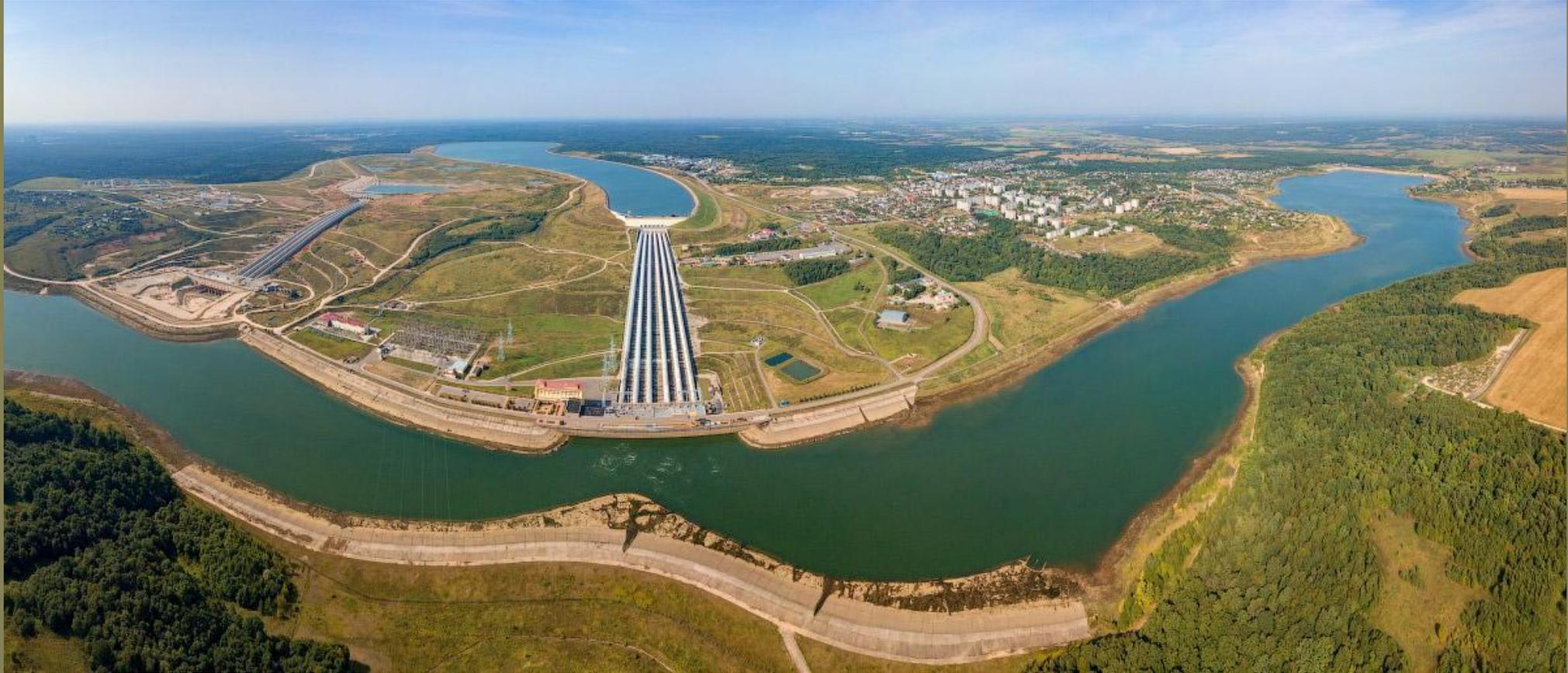
Является важным структурным элементом энергосистемы Центра, участвуя в автоматическом регулировании частоты и перетоков мощности, а также покрывая суточные пиковые нагрузки в Московской и Центральной энергосистемах.
