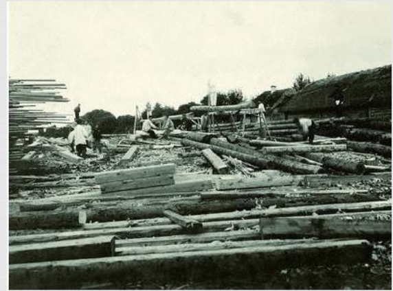
Начало строительства Свято-Успенской церкви
