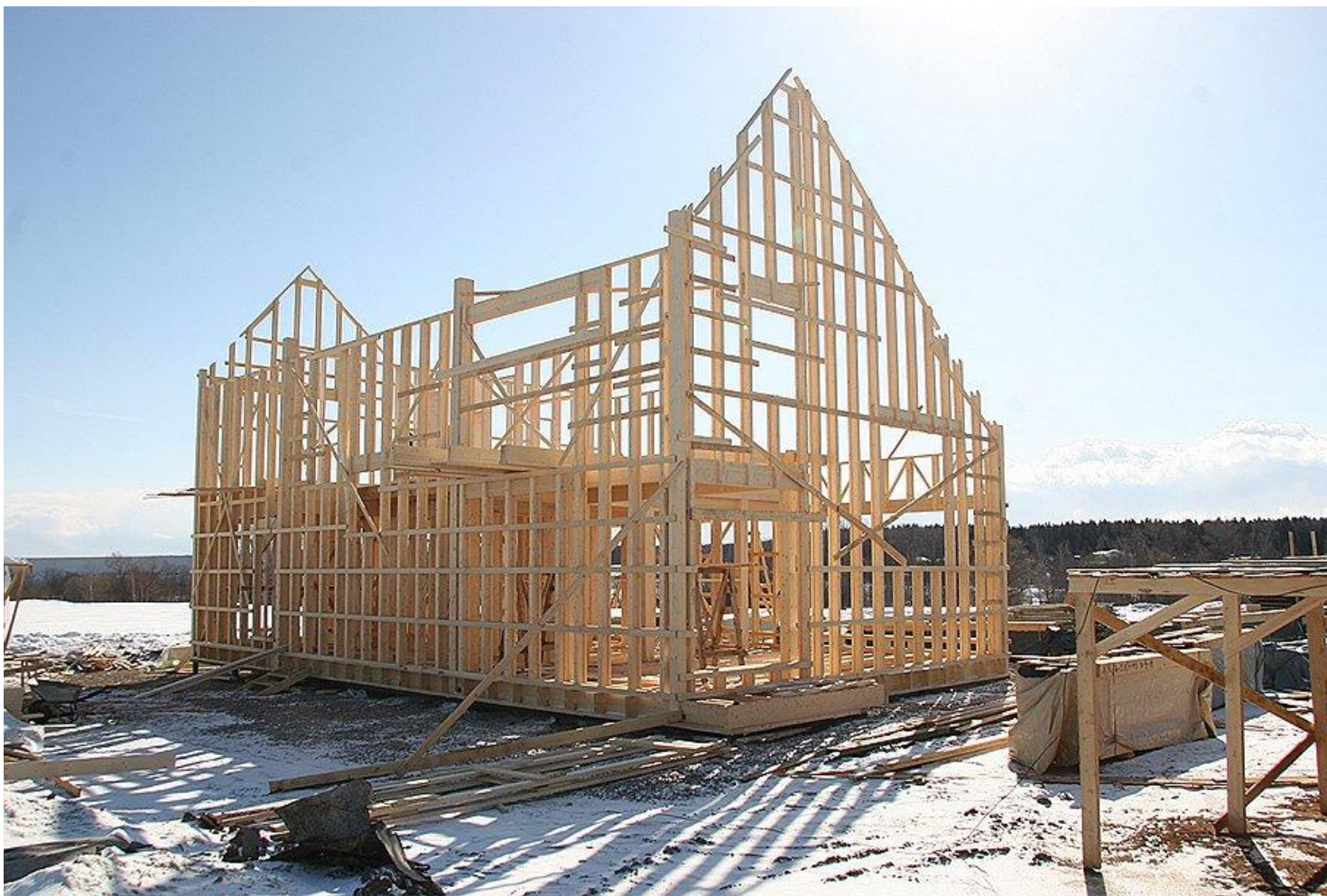
Рис. 7. Процесс строительства активного дома
