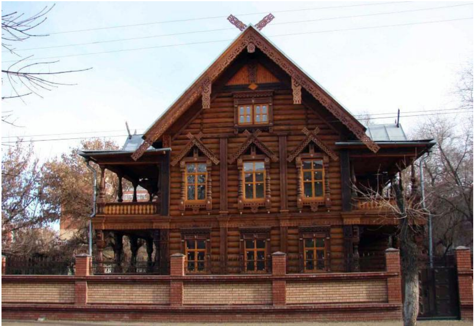
Г.Астрахань, дом купца Г.В. Тетюшинова Памятник жилой архитектуры 2-й половины XIX века
