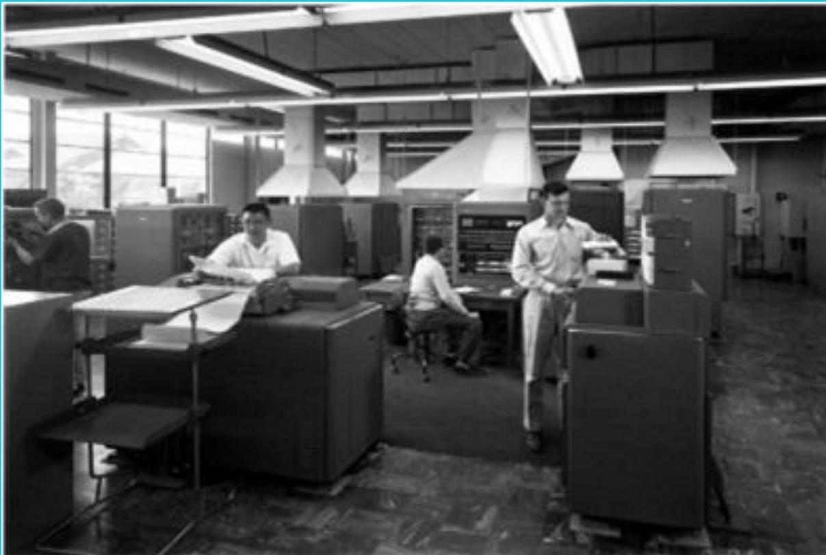
ЭВМ, начиная от UNIVAC и заканчивая БЭСМ-2 и первыми моделями ЭВМ "Минск" и "Урал", относятся к первому поколению вычислительных машин
