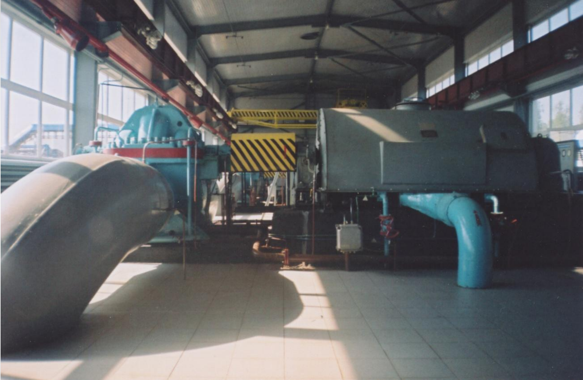
Рис.2.9 Насосный цех закрытого типа с объединенным залом
