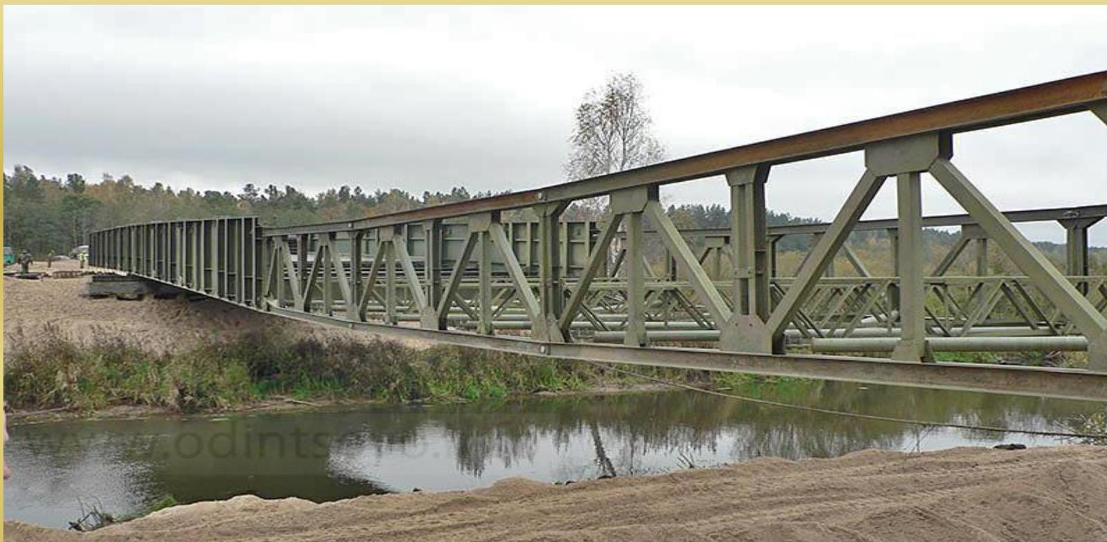
Большой автодорожный разборный мост **БАРМ** предназначен для строительства новых и восстановления разрушенных высоководных мостов на военно-автомобильных дорогах в короткие сроки. Из материальной части **БАРМ** возводятся однопролетные и многопролетные мосты с пролетами по 52,5 м под двухпутное движение с промежуточными опорами. В качестве опор могут быть также использованы сохранившиеся капитальные и временные опоры.
