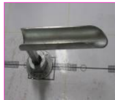
Отвод жгута с резиновым уплотнителем
