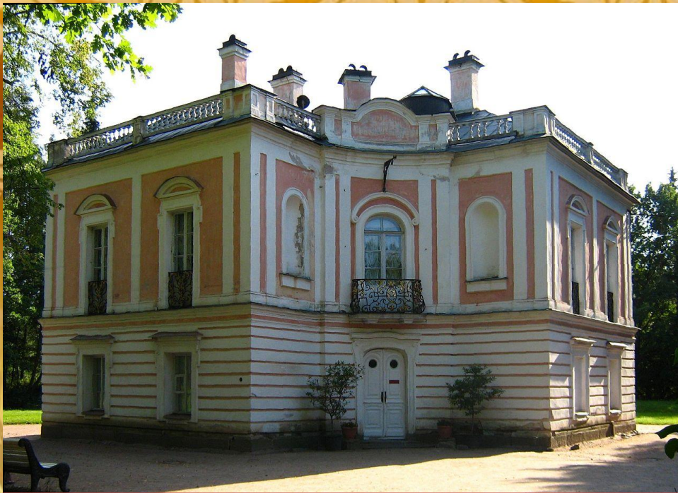
Ораниенбаум, дворец Петра III. Возведён для будущего императора по проекту архитектора Антонио Ринальди в 1758 – 1760
