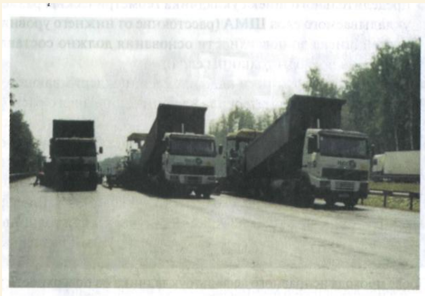
Рис. Загрузка ЩМАС в бункера асфальтоукладчиков
