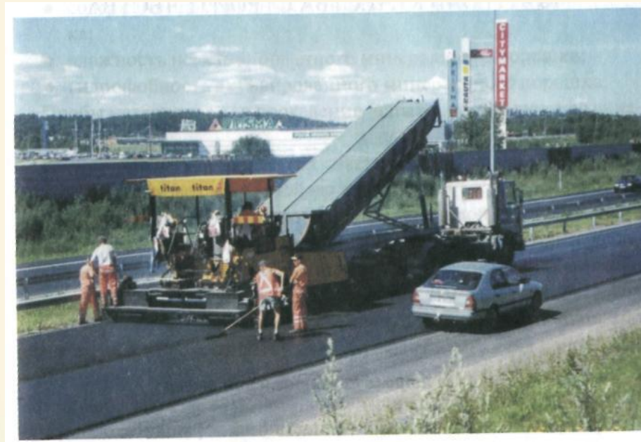
Рис. Укладка ЩМА одним асфальтоукладчиком
