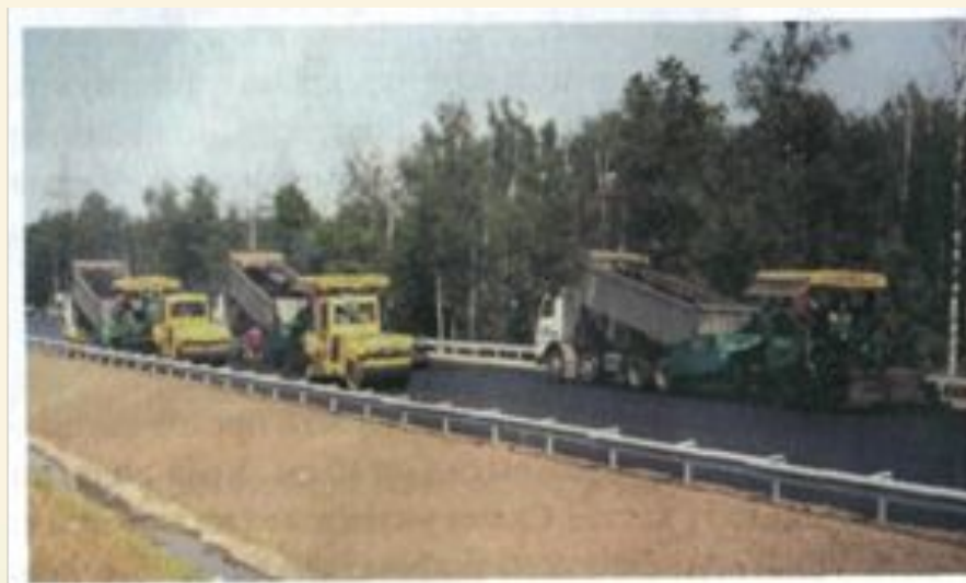
Рис. Устройство покрытия из ЩМА
