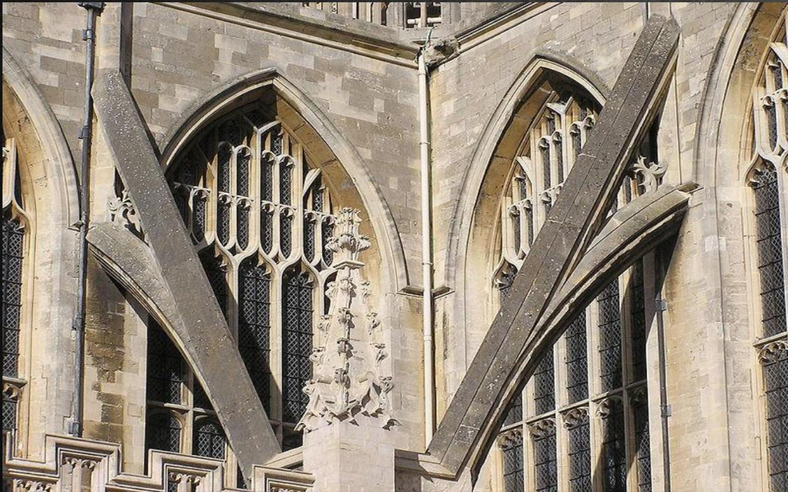
**Контрфорс (фр. contre force — «противодействующая сила»)** — вертикальная конструкция, представляющая собой либо выступающую часть стены, вертикальное ребро, либо отдельно стоящую опору, связанную со стеной аркбутаном.
