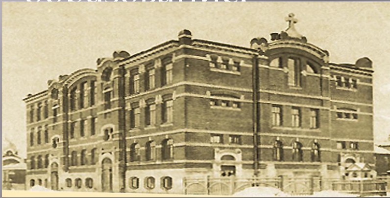
Церковно-приходская школа в Соркове. Архит. П. Малиновский.
