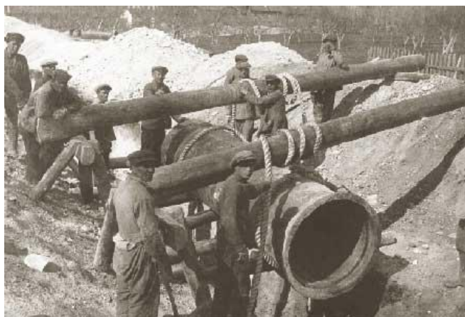
Строительство канализационного канала
