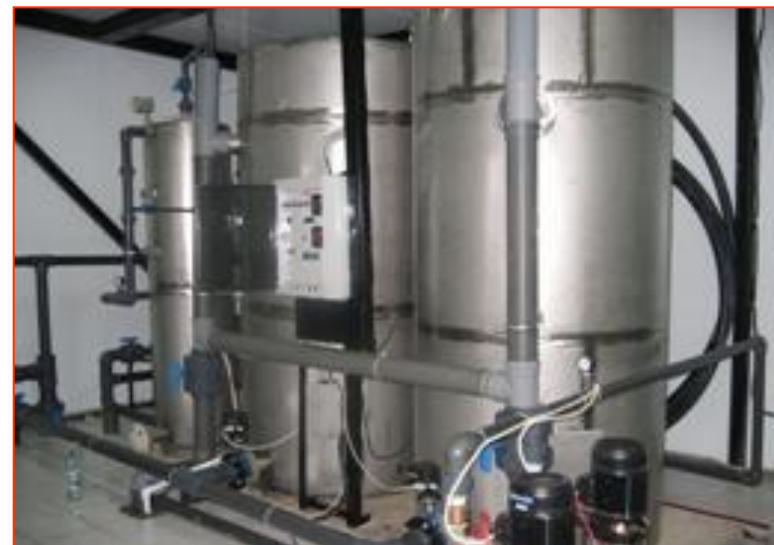
Рис. 2.4.1 Принципиальная технологическая схема (а) и установка (б) для удаления из подземных вод железа, марганца, сероводорода, аммиака и углекислоты:
