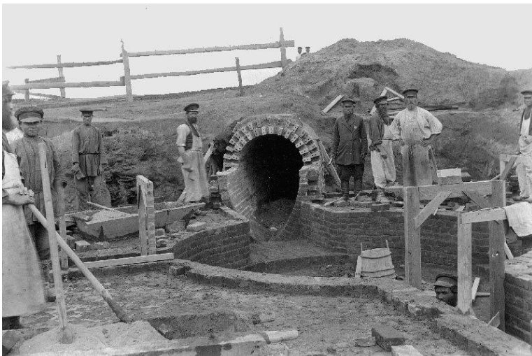
Строительство канализационного канала
