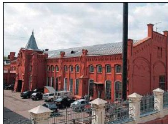
Городская канализация в Москве появилась почти на век позднее водопровода. Главная канализационная насосная станция, открытая в 1898 году
