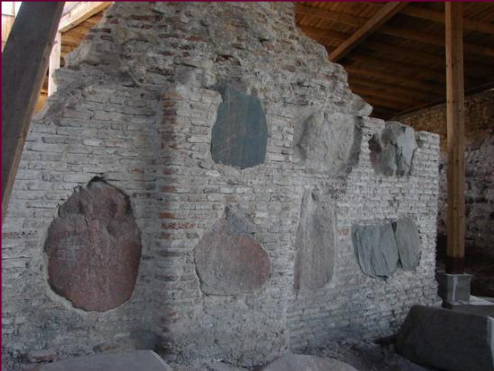
Нижняя церковь. Гродно. Фрагменты кладки стены.
