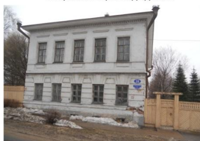
СУЩЕСТВУЮЩИЙ ВИД ЗДАНИЯ
