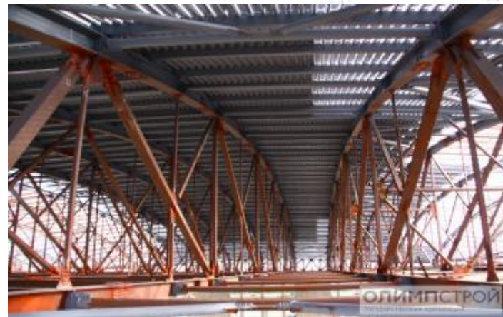
Система фахверковых ферм пролетом от 23 - 34 м
