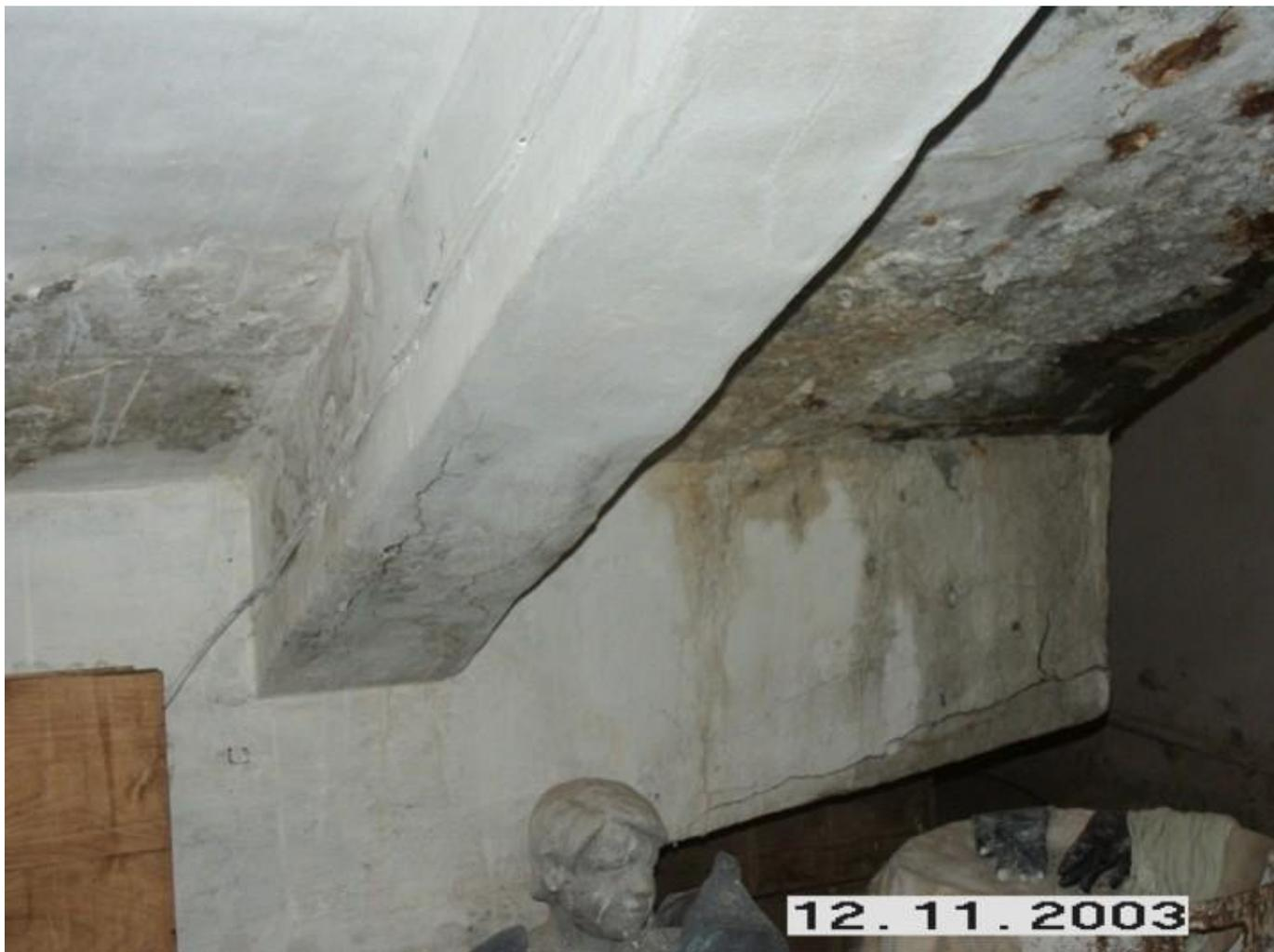
*Трещины в ж.б. балке по направлению расположения арматуры*
