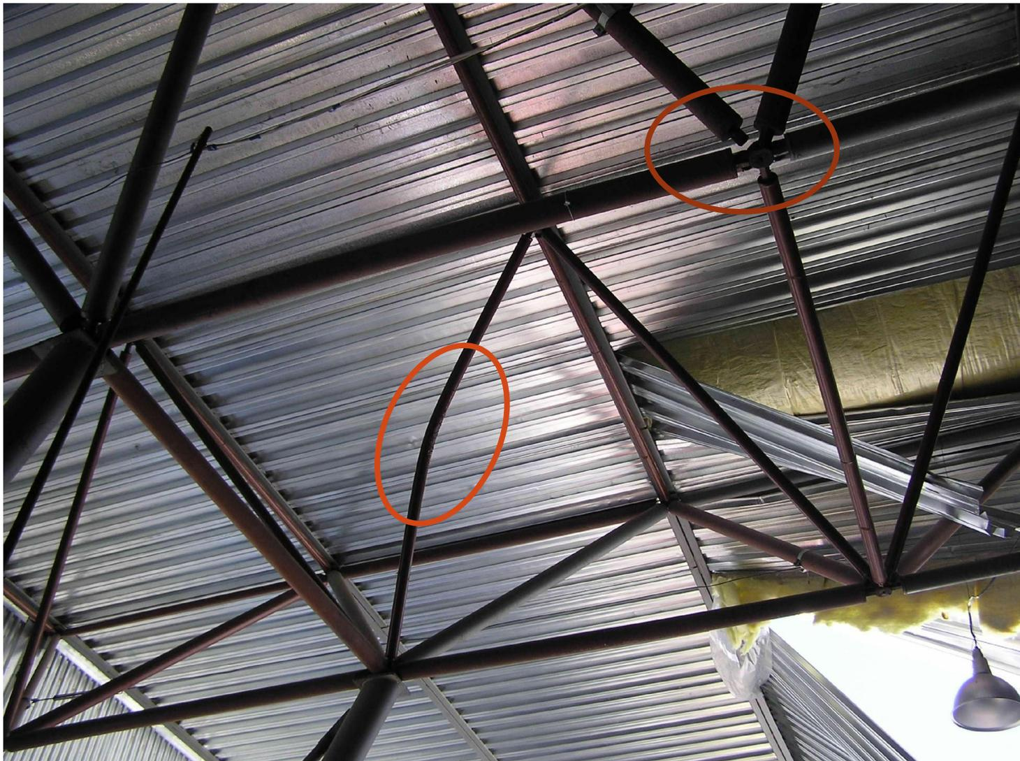
*Потеря устойчивости сжатого стержня и размыкание узла сопряжения растянутого стержня решетчатого ригеля*
