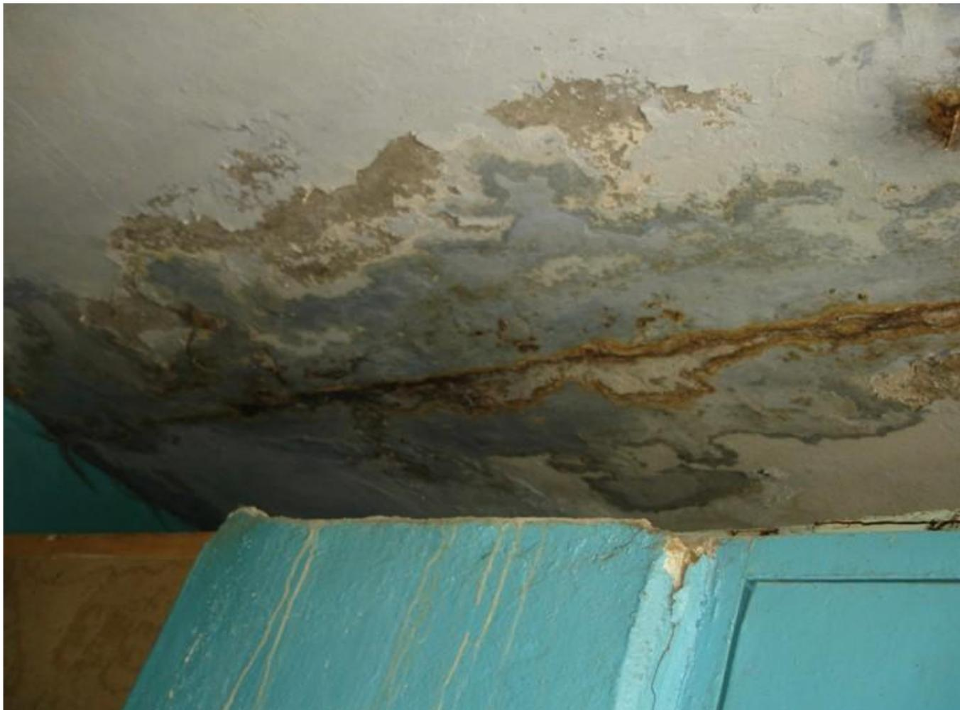
*Следы интенсивного увлажнения межэтажного перекрытия*
