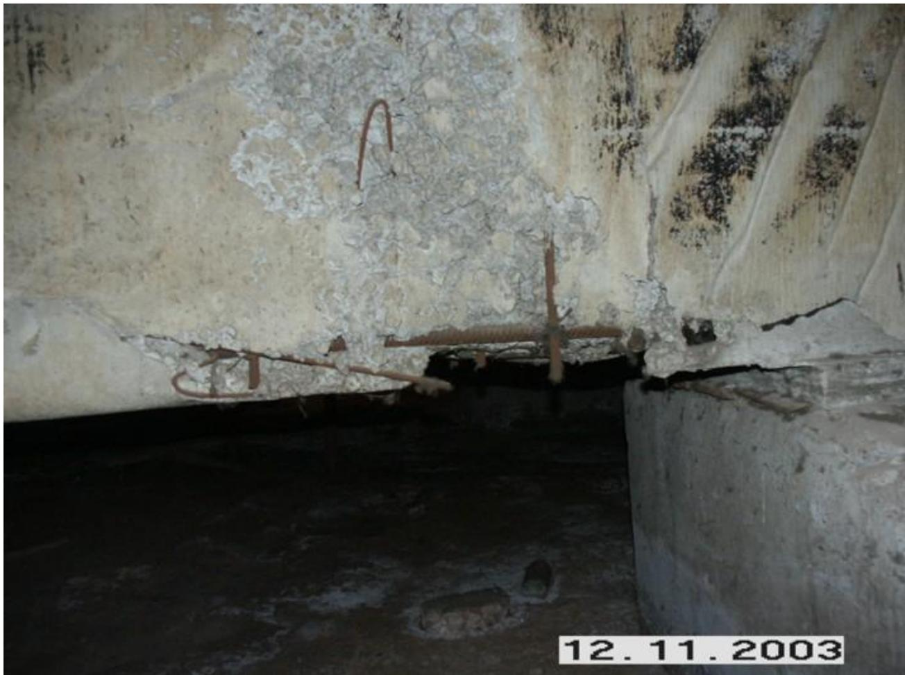
*Разрушение бетона в опорной зоне балки по наклонной полосе*
