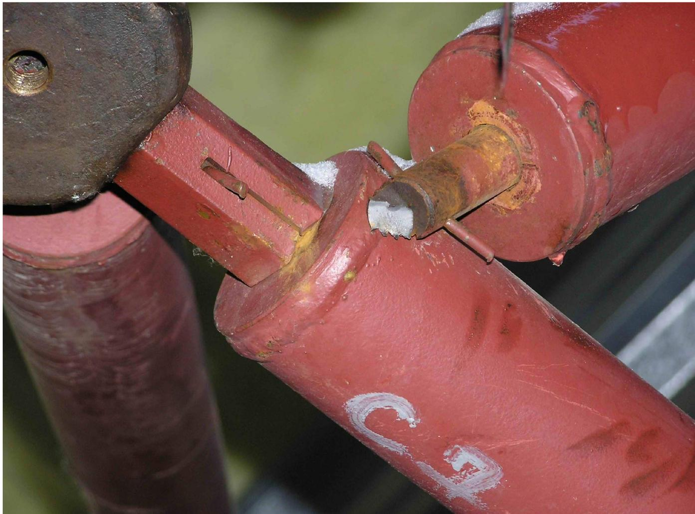
*Использование бракованного болта в конструкции (рабочая площадь сечения болта снижена на 50% имеющейся раковины)*
