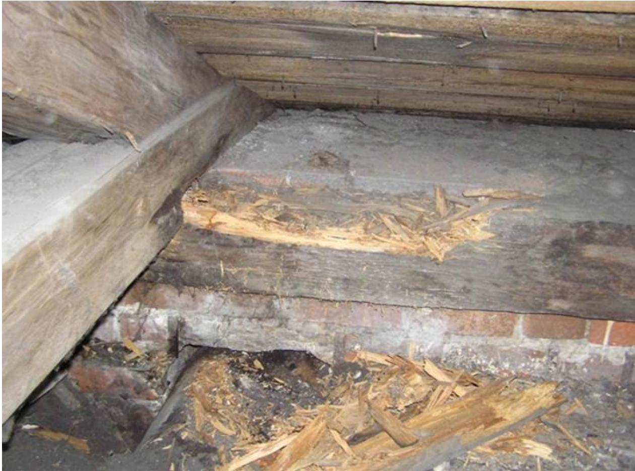
*Загнивание мауэрлатного бруса, опорного узла стропильной ноги и обрешетки стропильной крыши*
