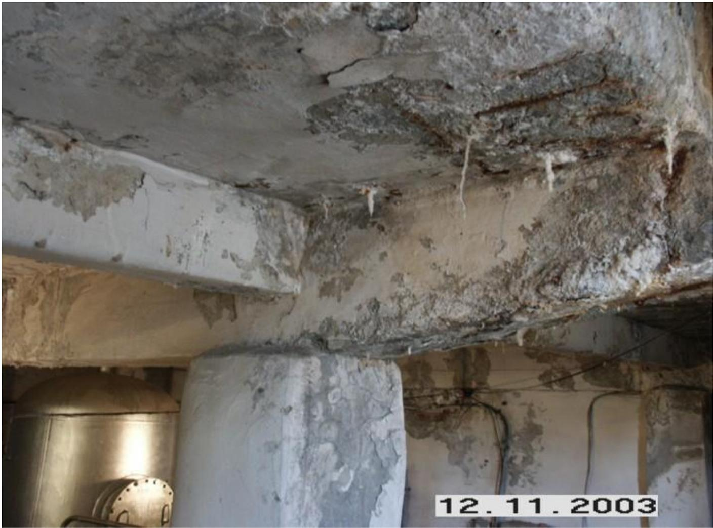
*Коррозия бетона (1 и 3 видов) и арматуры*
