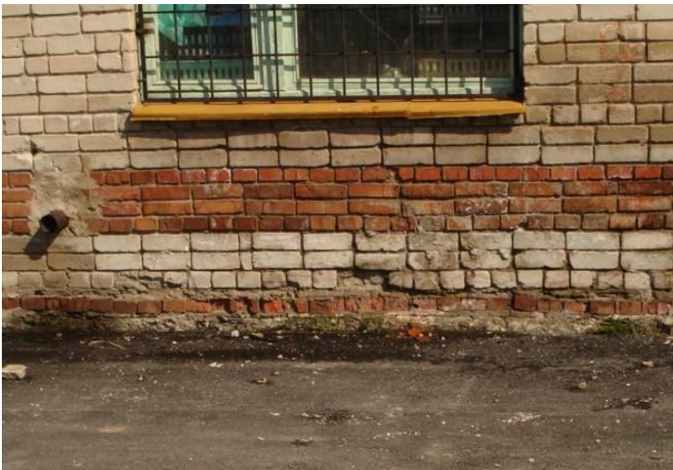
*Разрушение кладки цоколя (эрозия растворных швов, расслоение кирпичей)*
