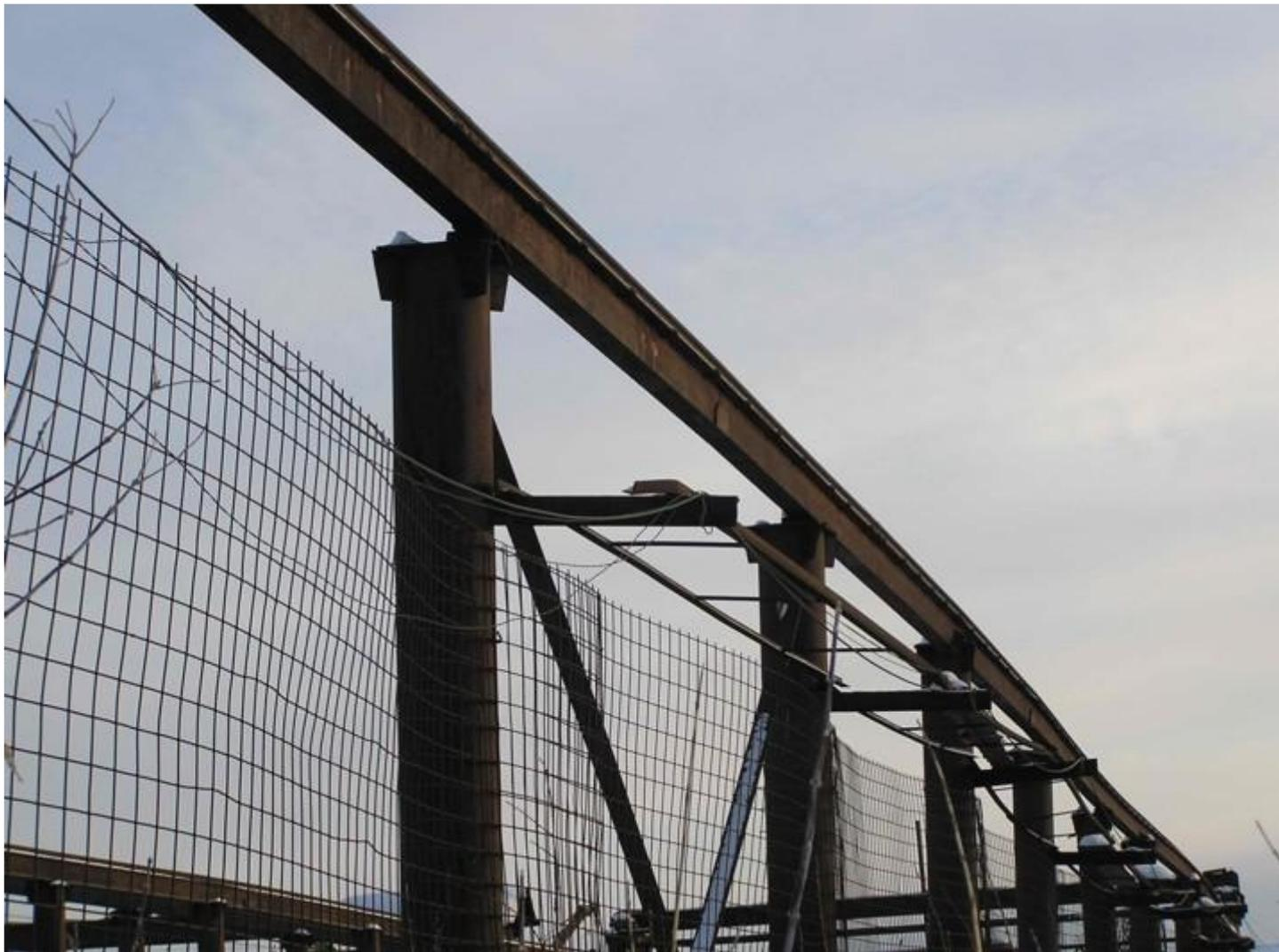
*Депланация подкрановой балки эстакады, внецентренная передача нагрузки на колонны*
