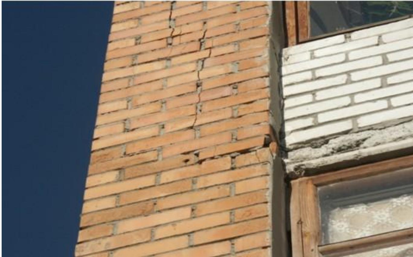
*Силовые трещины в кладке от перегрузки*
