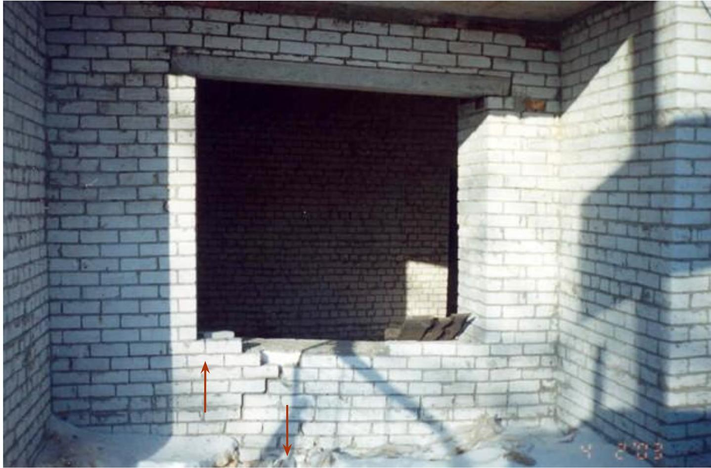
*Силовые трещины из-за деформаций сдвига*
