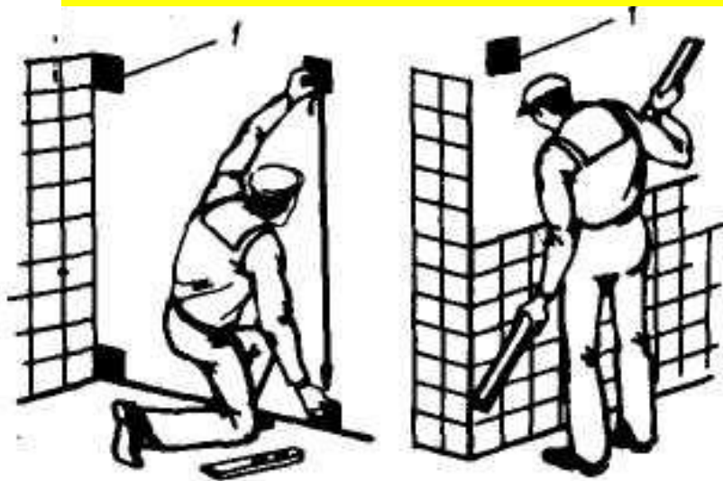
Установка маячных плиток;
