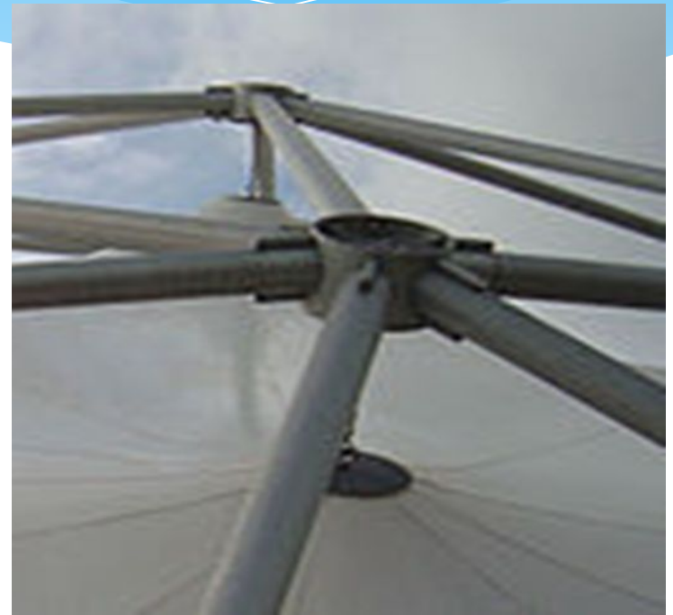
Узел сетчатого купола
