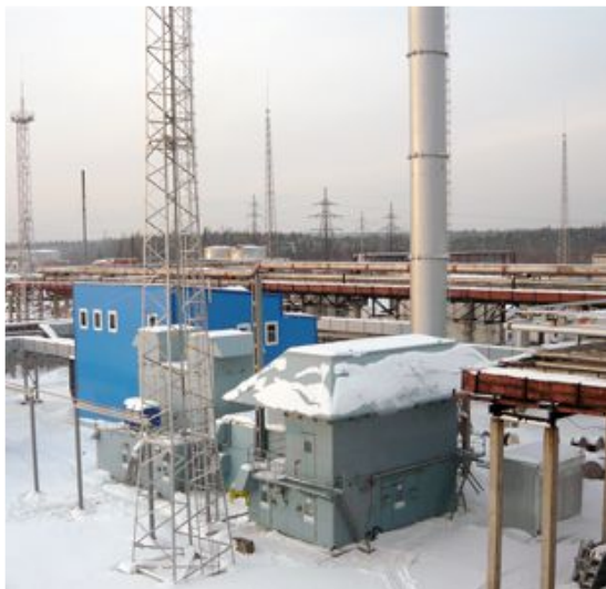
ОАО «Пермские моторы» ГТЭС-16ПА, ТЭЦ-13 г. Пермь для ЗАО «КЭС-Холдинг» (ПНР)
