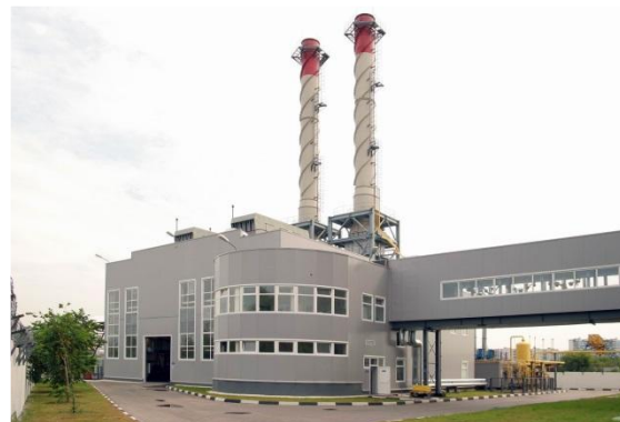
ОАО «НПО «Сатурн» ГТА-6PM в составе ГТУ-ТЭЦ в г. Москва (РТС «Курьянова») для Московского агентства по энергосбережению (2005г.)
