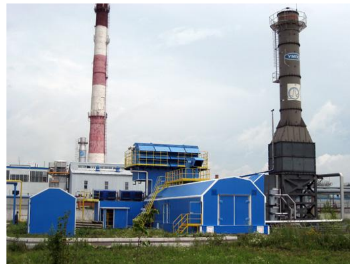
ЗАО «Уфа-АвиаГаз», ОАО «УМПО», МПП «Мотор» ГТЭ-18 «УФА», г. Уфа для ОАО «УМПО» (ПНР)
