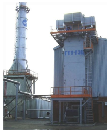
ЗАО «Уфа-Авиагаз», ОАО «УМПО», МПП «Мотор» ГТП-10/953 в Котельном цехе №4 г. Уфа, для ОАО «Башкирэнерго», (2005г.)
