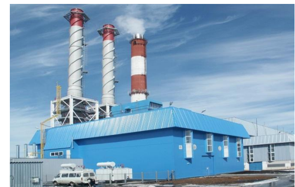
ОАО «НПО «Сатурн» ГТА-6PM в составе ГТУ-ТЭЦ в г. Москва (РТС «Пенягино») для Московского агентства по энергосбережению (2006г.)
