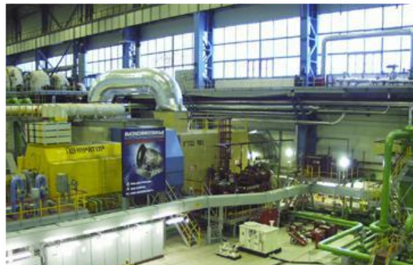
ОАО «НПО «Сатурн»
