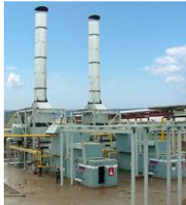
ОАО «Пермские моторы» ГТЭС «Урал-4000» в составе ГТУ-ТЭЦ «Агидель» для ООО «Башкирская генерирующая компания» (1997 г.)
