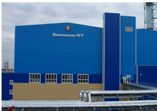
ОАО «НПО «Сатурн» ГТЭ-110 № 3 и №4, г. Комсомольск, Ивановская область ИВПГУ блок №1» для ОАО «Технопромэкспорт» (2007г.)
