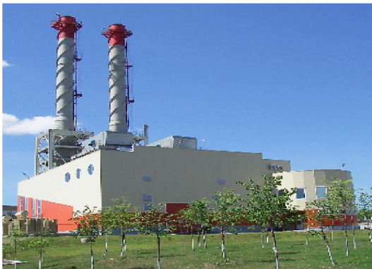
ОАО «НПО «Сатурн» ГТА-6PM в составе ГТУ-ТЭЦ в г. Москва (РТС «Перedelкино») для Московского агентства по энергосбережению (2005г.)
