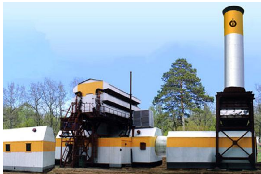
ОАО «Моторостроитель», СНТК им. Кузнецова НК-14 ЭБР, г. Медногорск для ОАО «Оренбургэнерго», (ПНР)
