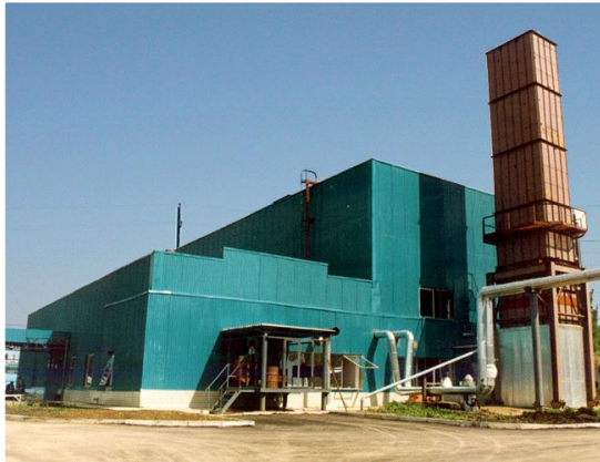
ОАО «Пермские моторы» ГТЭС «Урал-4000» в составе ГТУ-ТЭЦ «Шигили» для ОАО «Башкирэнерго» (1997 г.)
