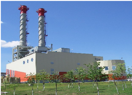
ОАО «НПО «Сатурн» ГТА-6PM в составе ГТУ-ТЭЦ в г. Москва (РТС «Перedelкино») для Московского агентства по энергосбережению (2005г.)
