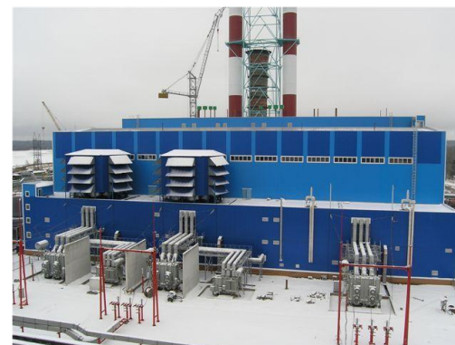
ОАО «НПО «Сатурн» ГТЭ-110 №6 и №7, г. Комсомольск, Ивановская обл. ИВПГУ блок №2, для ОАО «ИНТЕР РАО ЕЭС», филиал «Ивановские ПГУ» (строительство)
