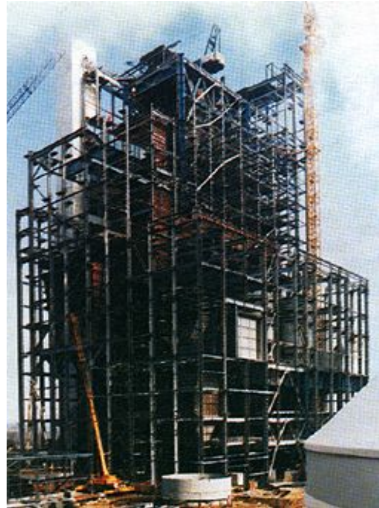
Возведение котлоагрегата
