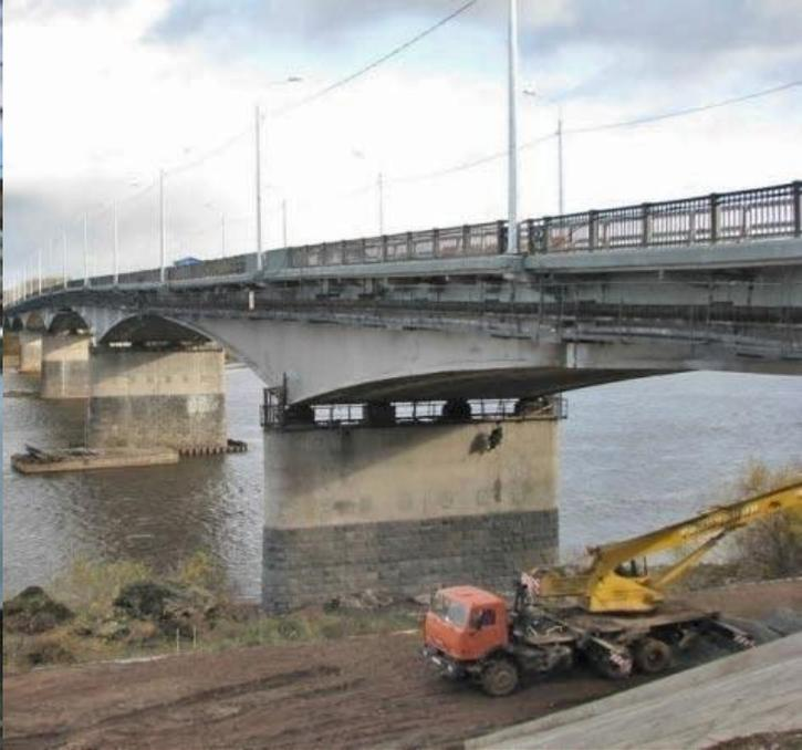
На рисунке представлена фотография моста через Волгу в районе г. Кимры, реконструкция которого закончилась в ноябре 2007 года. Покрытие этого моста было выполнено из легкого конструкционного фибробетона на основе базальтовой микрофибры, модифицированной нанокластерами углерода.
