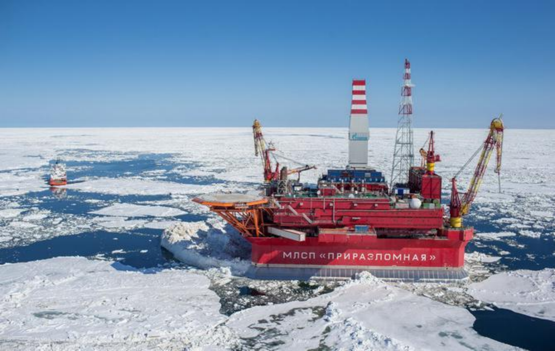
Стационарная платформа «Приразломная» с кессонным основанием /pro-arktisk.ru/
