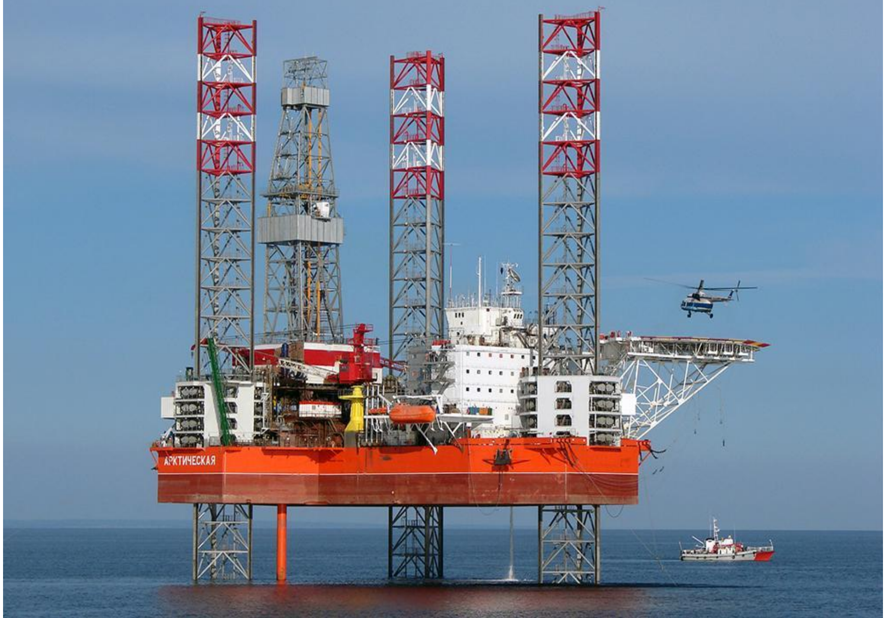
Плавучая буровая установка с выдвжными опорами «Арктическая» /pro-arktiki.ru/
