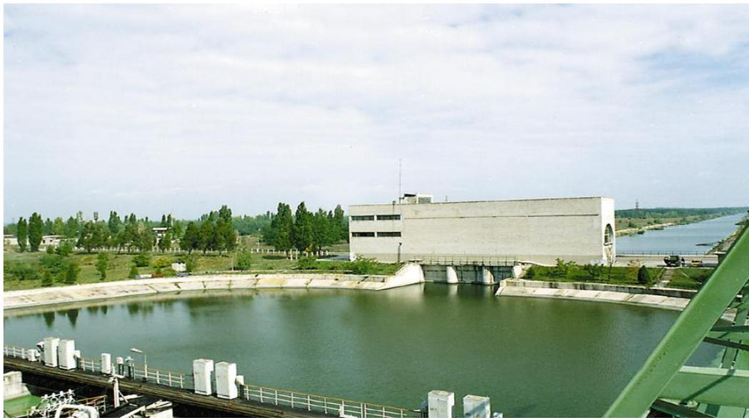
**Водосбросовые сооружения** — гидротехнические сооружения, предназначенные для сброса излишней (паводковой) воды из водохранилища, а также пропуска воды в нижний бьеф.
