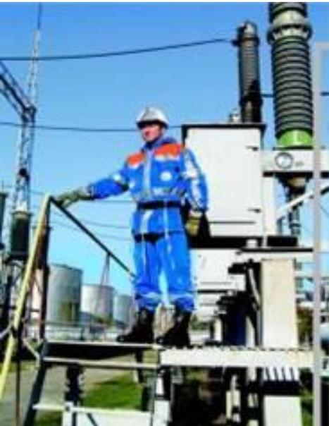
Экранирующие устройства выполняют из токопроводящего материала.
