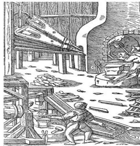
Кузнецы, родоначальники сварки металла. Гравюра Г.Агрикола
