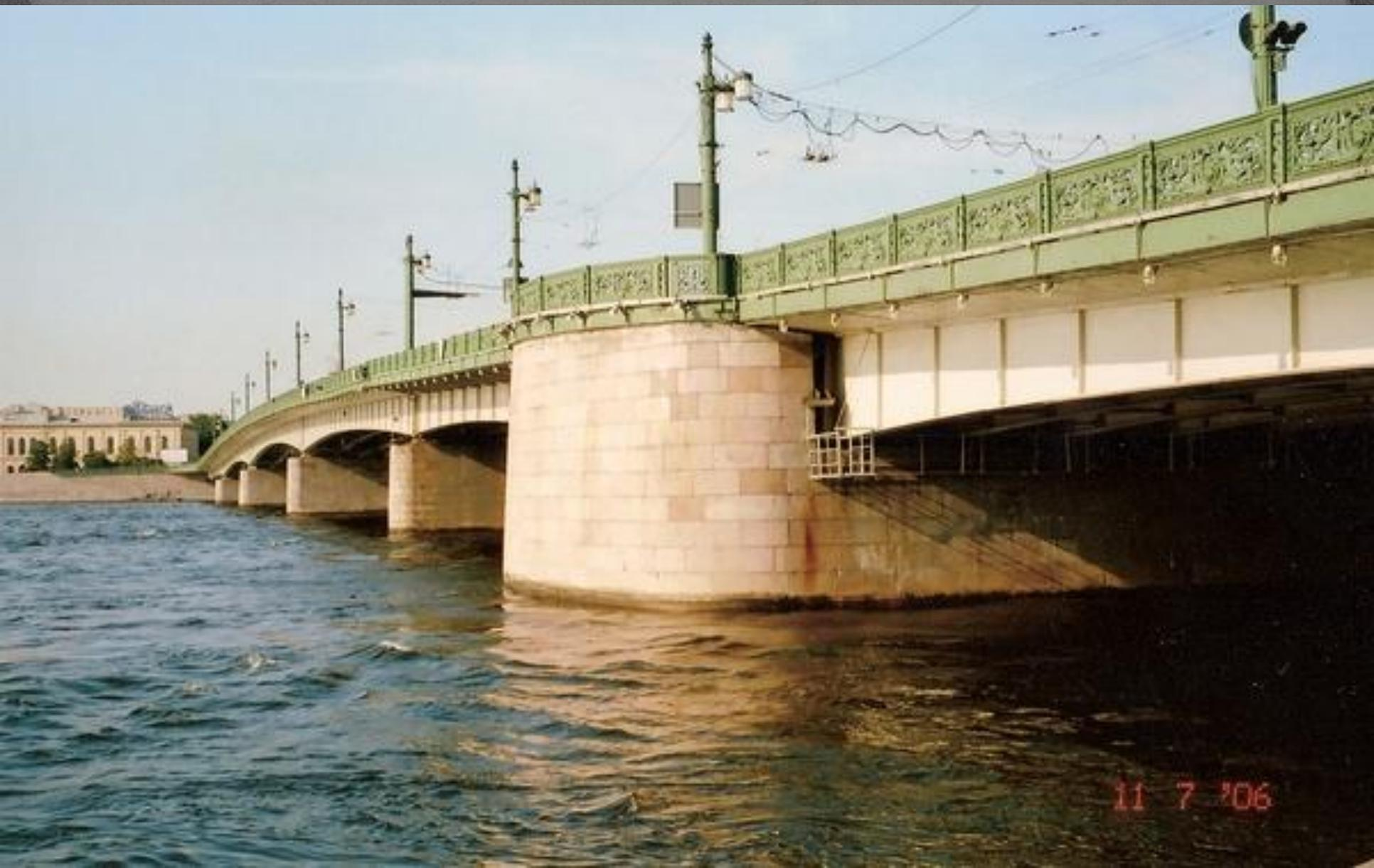
Литейный мост отличается красивым рисунком чугунных перил. Разводной пролет Литейного моста состоит из одного крыла. Этот пролёт – один из самых больших в мире: его ширина 50 метров. Всего у Литейного моста 6 пролётов. Литейный мост стал первым получившим электрическое освещение
