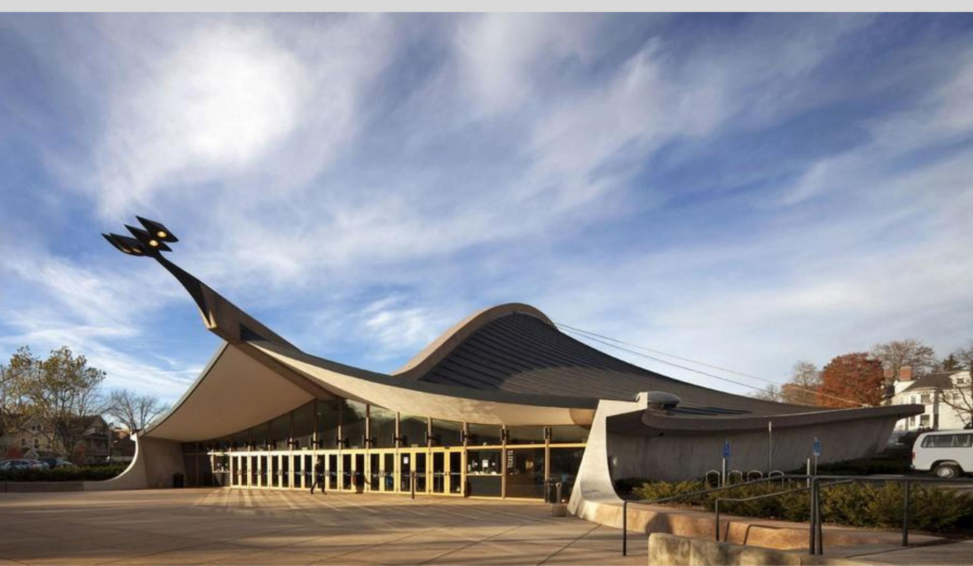
**Рис. 4.1. Крытая спортивная арена на 2900 зрителей в Нью-Хавене штат Коннектикут США (здание перекрыто параболической аркой пролетом 79м с консолями по 12 м, к которой крепится вантовая конструкция из сетки стальных тросов)**
