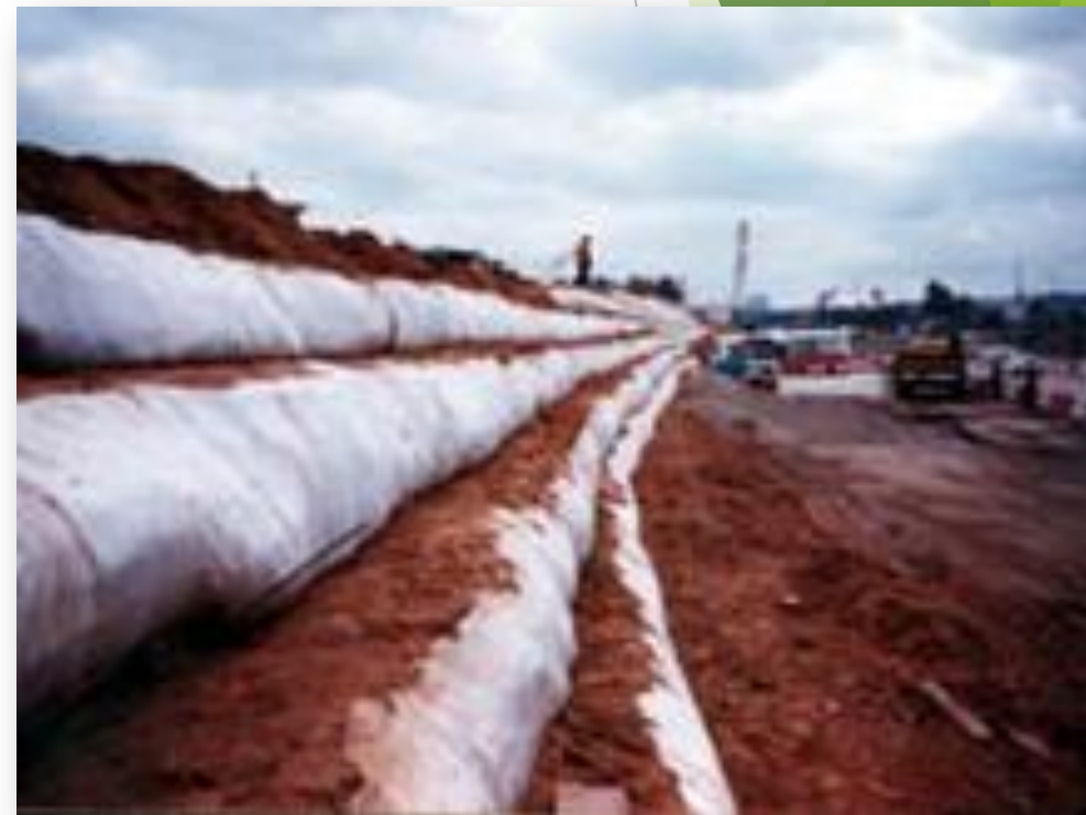
Подпорная стенка из грунта армированного геотекстилем.
