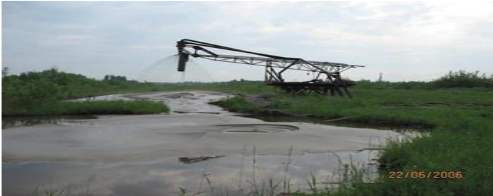
Закладка провалов отработанных скважин хвостами обогащения на Бакчарском месторождении
